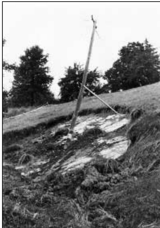
Figure 19: Landslides damaged or destroyed electrical, telephone, and water networks. The photograph is from Črni Vrh. Slika 19: Zemeljski plazovi in usadi so poškodovali in uničili tudi električno, telefonsko in vodovodno omrežje. Posnetek je iz Črnega Vrha.
