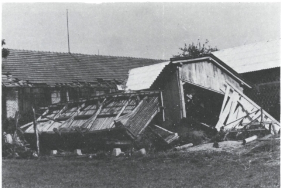
Sl. 19. Prekucnjeni koruznjaki ter podrte lesene šupe v Šalamencih pričajo o silovitosti viharja. Streho na hiši pa so že pred našim ogledom za silo pokrili.
