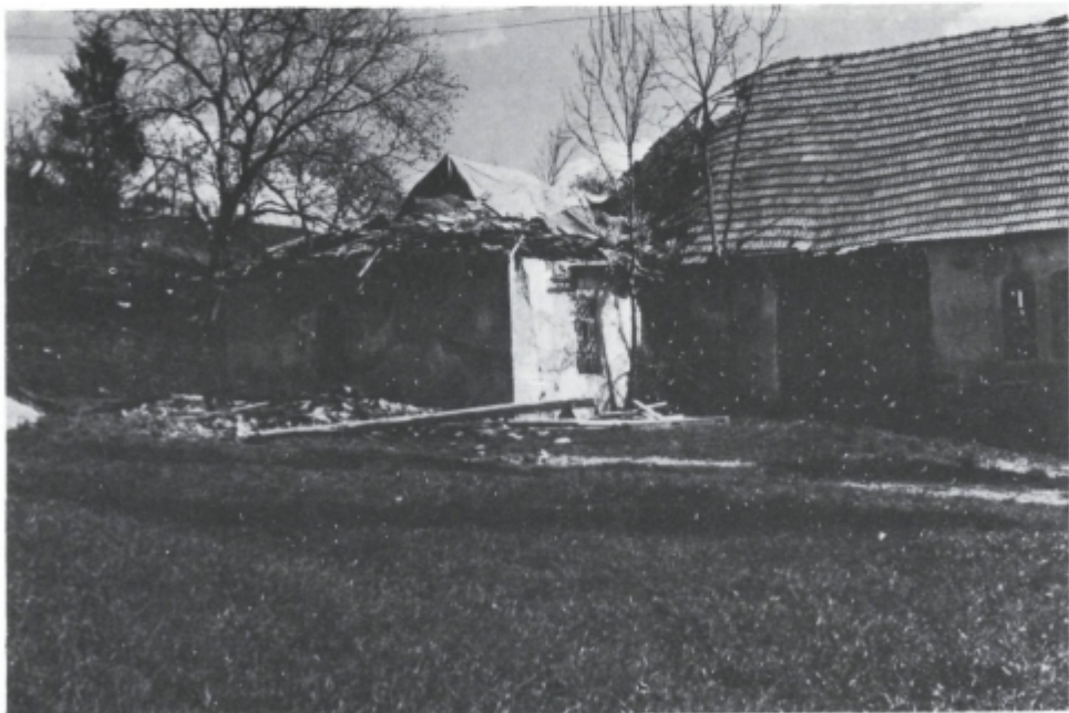
Sl. 32. V viharju skoraj povsem uničen hlev pri Kolariču v Jareninskem Vrh. Manj poškodovano streho na desni strani slike pa so zasilo že pokrili.
