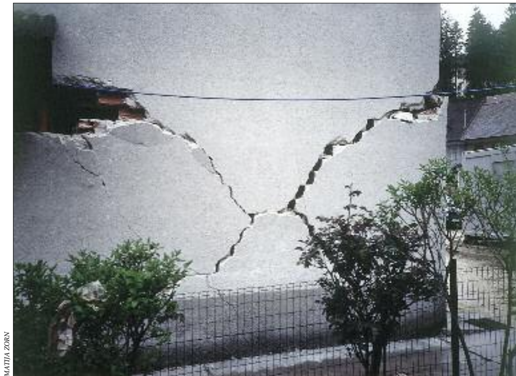
Slika 6: Značilna poškodba na hišah v Bovcu ob potresu leta 1998.
