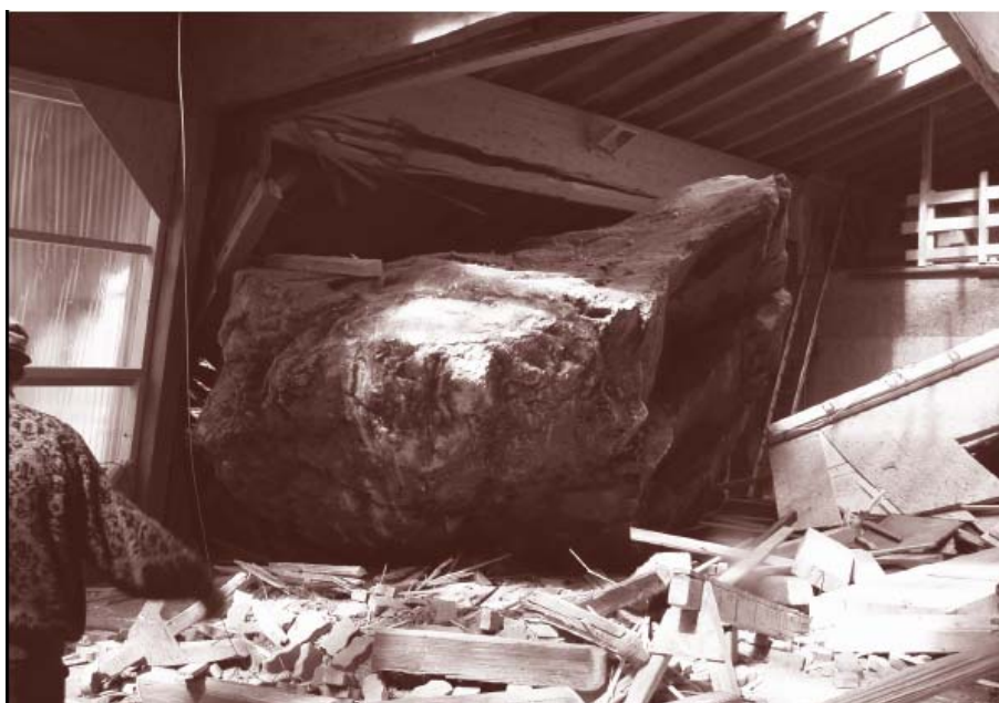
Conséquences d'une chute de pierres à Längenfeld, Tyrol (Autriche)
