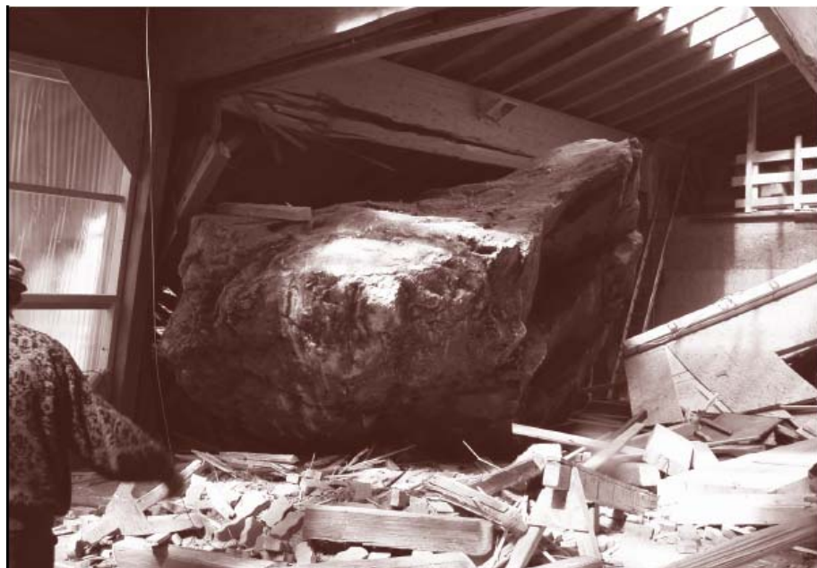
Folgen eines Steinschlags in Längenfeld, Tirol (Österreich)
