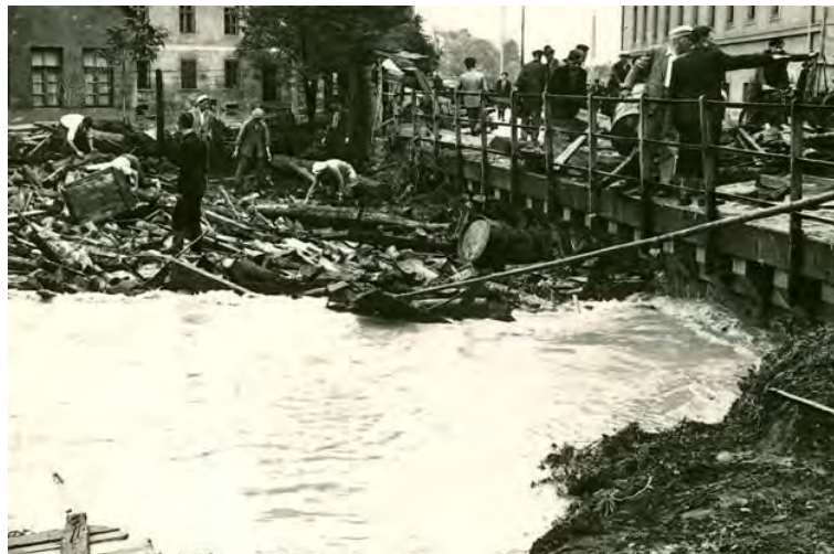
Slika 5.4: Očiščevalna dela na mostu na Mariborski cesti v Celju ob poplavi leta 1954 (Gasilsko društvo Gaberje, Osrednja knjižnica Celje , https://bit.ly/3Gn4ha1 ).
