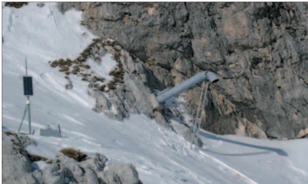
Slika 3: Strelna cev sistema Gazex nad smučiščem Kanin. Kontrolno mesto za proženje je opremljeno s plinohramom (propan, kisik) in elektronsko opremo za daljinsko upravljanje. Bolj kot pozimi je objekt moteč v kopnem delu leta. Po morebitni odstranitvi bi ostali le temelji (fotografija: Blaž Komac).
