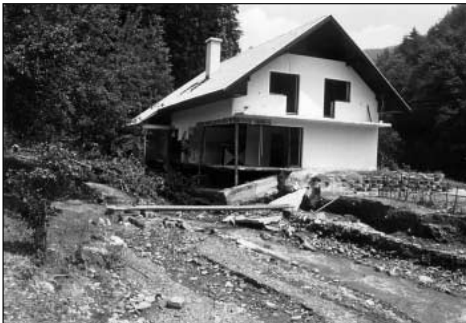
Figure 9: The torrential Prešnik tributary undercut the foundation of a newly built house directly beside the riverbed. In the catchment area of the Kotredeščica, none of the older houses stand so near the streams. Slika 9: Hudourniški pritok Prešnik je povsem spodjedel temelje pred kratkim zgrajene stanovanjske hiše. Zgradili so jo na neprimerni lokaciji neposredno ob strugi. V povirnih delih Kotredeščice ni starejših hiš, ki bi stale tako blizu potokov.
