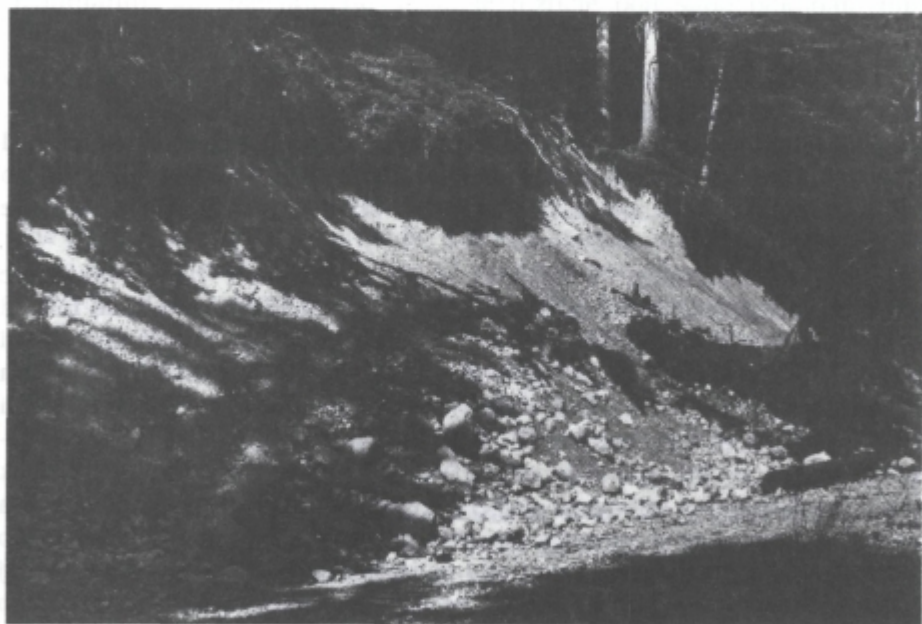
Foto 3 Nove gozdne ceste so marsikje izpodkopale morensko in drugo pobočno gradivo. Kot posledica porušenega pobočnega ravnovesja so številni usadi nevezanih sedimentov. Primer blizu hriba Žaga južno od Kranjske Gore.
