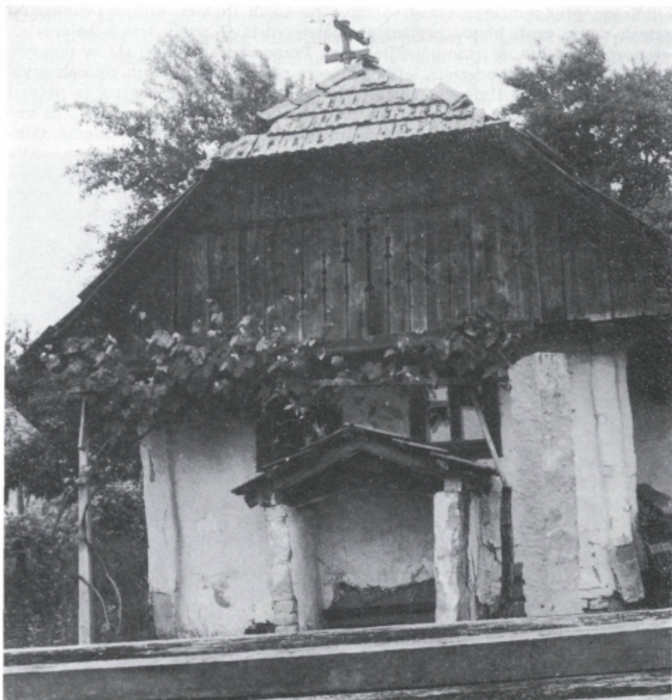
Sl. 6 Stara zidanica pred obnovo.
