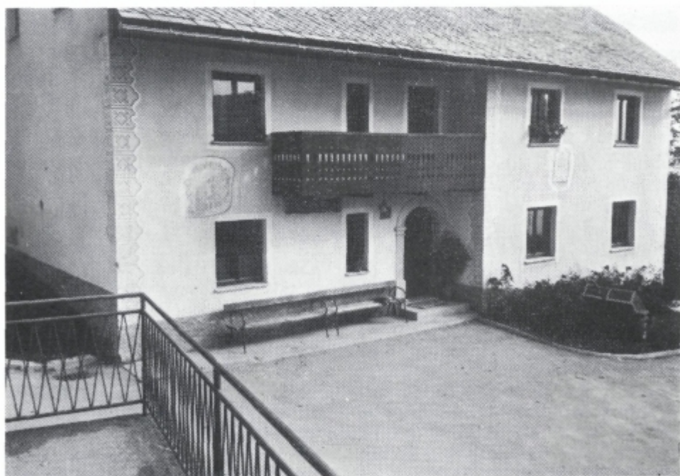
Sl. 9. Turistična Tavčarjeva kmetija v Dolenji Žetini, ki so jo obnovili, deloma pa je še ohranila značilno podobo nekdanje kmečke hiše.
