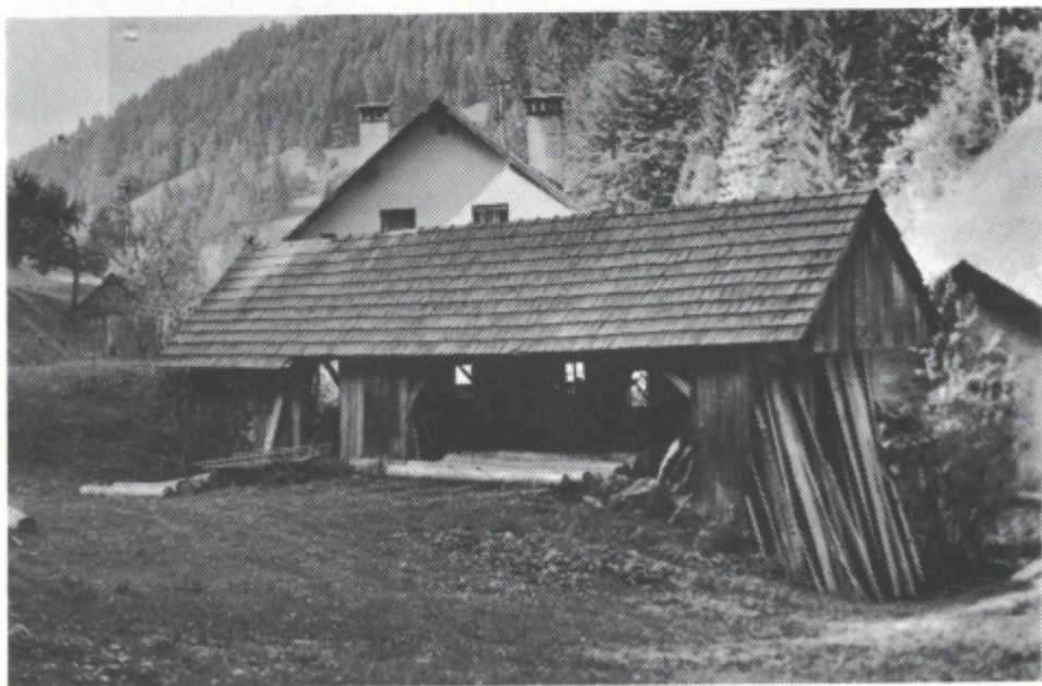
Sl. 5. Podolgarjevo žago v Butajnovi pod Šentjoštom je poganjala Mala voda, ki izvira za Črnim vrhom (712 m). Žaga je imela vodni pogon na vreteno, ki so ga opustili po letu 1960; odtlej dalje jo poganja elektromotor.
