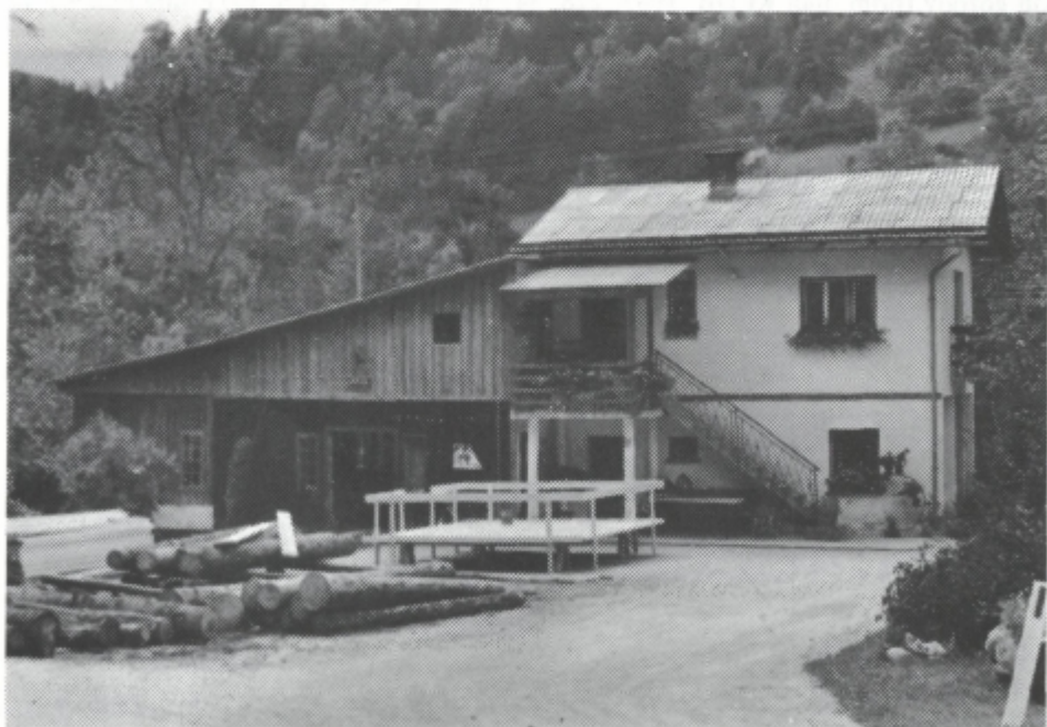
Sl. 4. Ogrinčeva (nekdaj grajska — Auerspergova) žaga pod Turjakom je ena izmed redkih, ki še obratujejo na vodni pogon. Od leta 1918 ima vgrajeno francisovo vodno turbino z močjo 5,5 kW, ki poganja venecijanko z dvema listoma.
