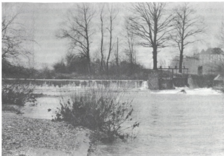
Sl. 6. Jez na Gradaščici z zapornicami za odtok vode v kanal.
