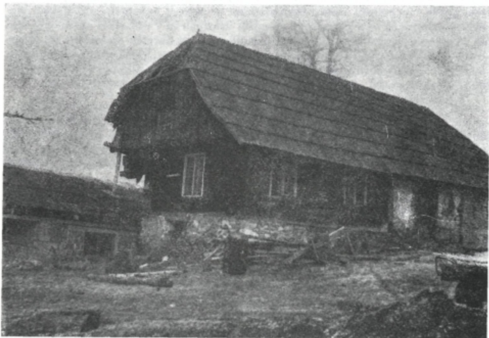
Sl. 12. Kmetija Višnar v Mali Mislinji (936 m). Ker starosvetna, tipična pollesena hiša v letih 1966—1976 ni bila obljudena in vzdrževana, je novi lastnik menil, da se je ne spleča več obnavljati. Poleg je začel graditi novo hišo. Družina z gospodinjo, tremi otroki in z gospodarjem v službi pa brez pomoči družbe le ne zmore potrebnih sredstev. Zato je gradnja hiše zastala pri prvi plošči, nad katero so postavili zasilno streho, da ne zamaka v kletno stanovanje.
