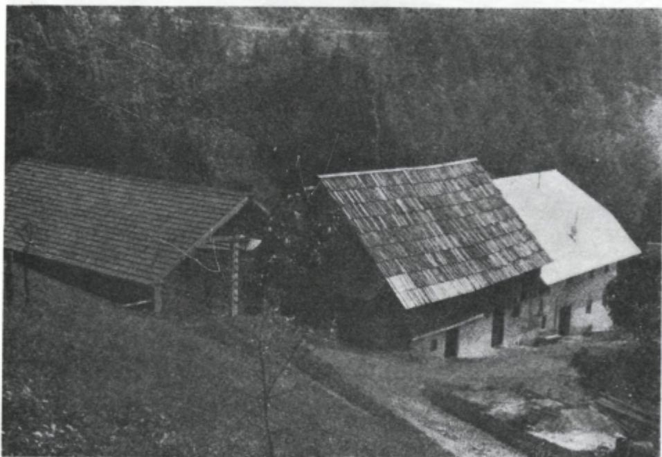
Sl. 11. Javornik (865 m) na Rebrju v Podljubelju je obnovil hišo v stegnjenem domu in jo prekril s salonitno kritino, ki se močno loči od gospodarskega poslopja, kritega s skodlami
