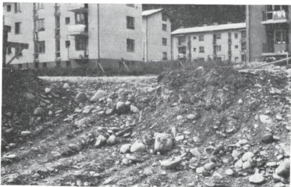
Sl. 9. Takšen prod so razkrili v vršaju Češnjice pri izkopu temeljev za številne nove stanovanjske bloke v istoimenskem naselju
