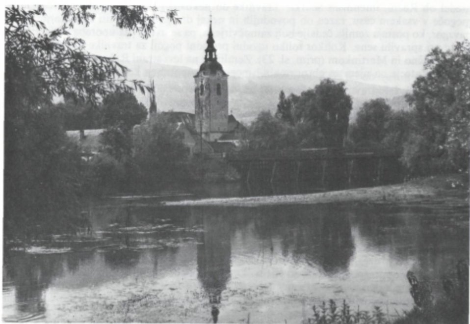
Sl. 49. Kostonjeviča na Krki stoji na poplavnem svetu. Dostop v mesto na otoku je mogoč po dveh lesenih mostovih ter brvi. Pogled na zahodni most, ki je naslonjen na številne lesene opornike
