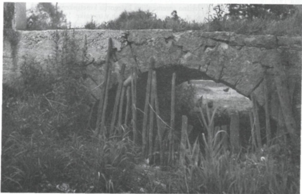
Sl. 45. Vodni prepust pod cesto Dobrava – Šentjernej pri naselju Roje. Zgornji del prepusta ima leseno »ograjo« oziroma »brano«, ki preprečuje povodnjim, da bi odnašale z dvorišč najrazličnejše predmete
