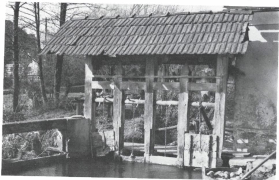
Sl. 31. Z jezovi je bila naravnana in pogojena izraba pogonske moči potokov. Pogled na jez Smrekarjevega mlina na Radúlji v Žalogu. Mlin, ki je imel tri pare kamnov in stope, danes melje le za dom
