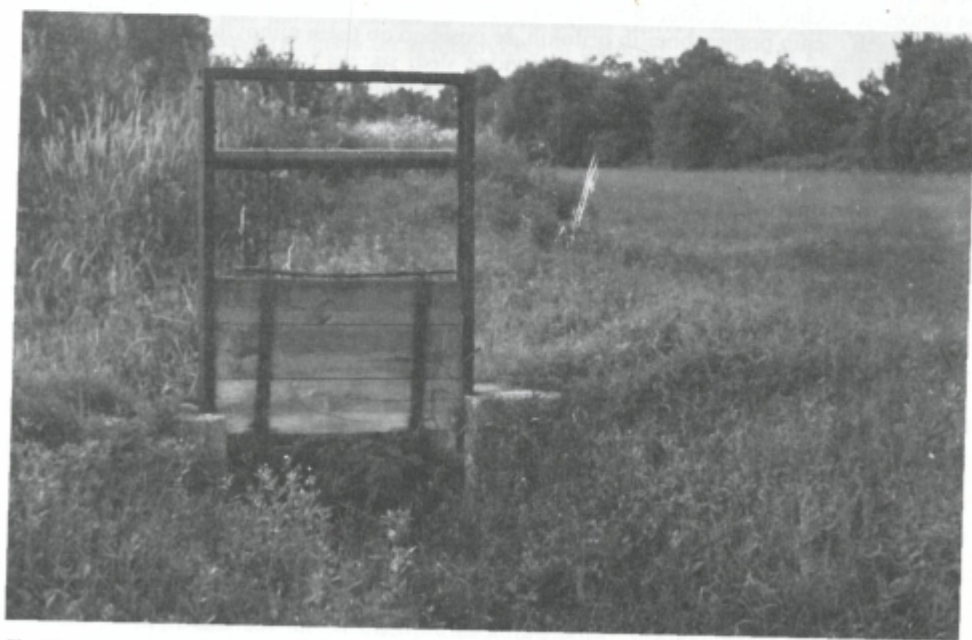
Sl. 24. Opušteni jez na Velikovaškem potoku (levi pritok Senuše), ki je služil odvajanju poplavnih voda v razbremenilnik. Jez stoji sredi Travnikov med Gržečo vasjo in Velikim Podlogom
