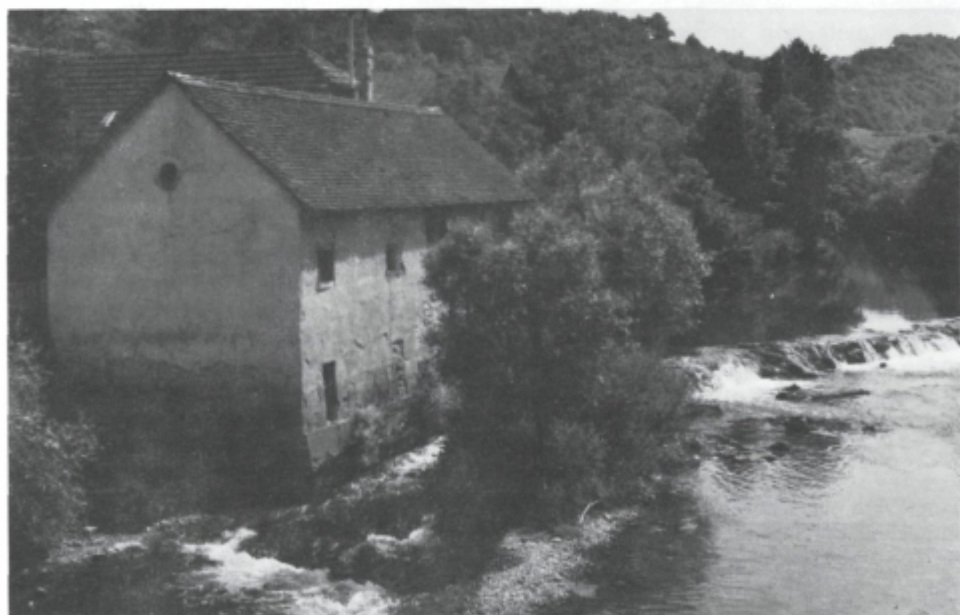
Sl. 38. Tudi Lopatičev mlin na Krki (Velike Malence) so opustili po zadnji vojni. Do leta 1955 so poganjala 4 kolesa na lopate 4 pare mlinskih kamnov. Tedaj so preuredili pogon na eno samo veliko vodno kolo, ki je poganjala obrat vse do njegove opustitve v letu 1959
