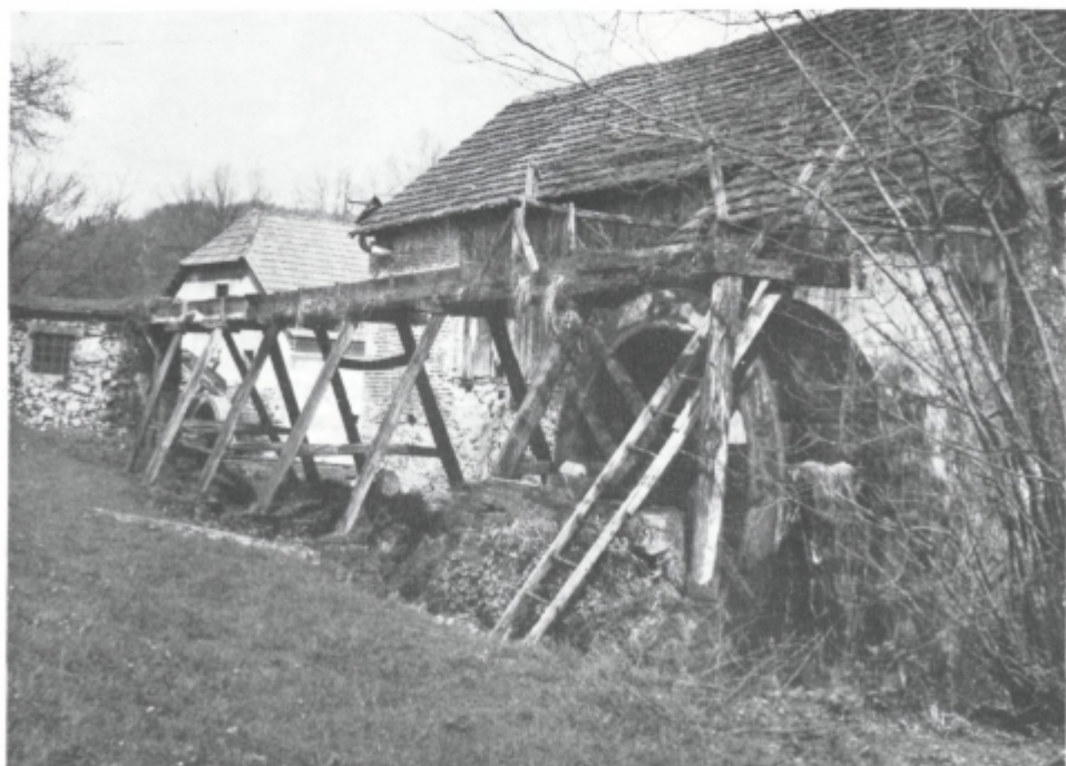
Sl. 34. Vajsova žaga in mlin sta ena izmed redkih obratov na vodni pogon, ki še izrabljata pogonsko moč Račne (Dolenje Radulje)
