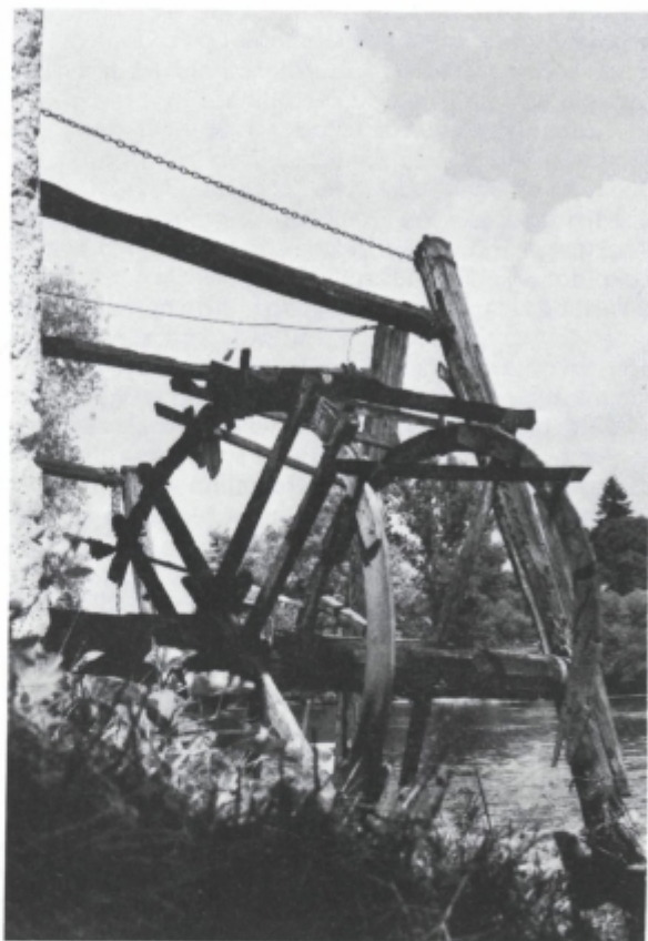
Sl. 39. Razpadajoče vodno pogonsko kolo Dvornikovega mlina v Krški vasi. Nekdaj je imel mlin celo 5 pogonskih koles, ki so jih združili v letih med obema vojnama v eno samo veliko kolo na lopate. Mlin so opustili sredi 60. let
