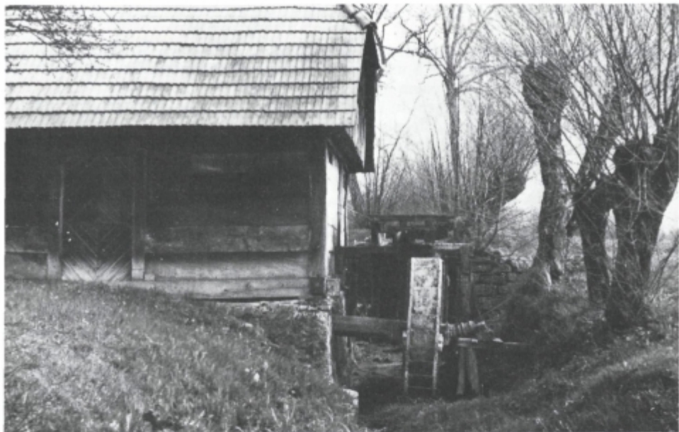
Sl. 37. Malenškov mlin na Lokavcu (naselje Zaloke) so opustili 1974. leta. Mlin je bil v leseni stavbi, kjer sta bila dva para mlinskih kamnov in stope. Poganjala so ga tri kolesa na korce
