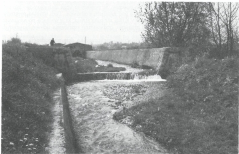
Sl. 22. Hudourniško Kobilščico, ki je povzročala mlinarjem in žagarjem obilo skrbi, so regulirali večkrat. Pogled na del njene zavarovane struge med Dolenjo Brezovico in Dolenjim Vrhpoljem
