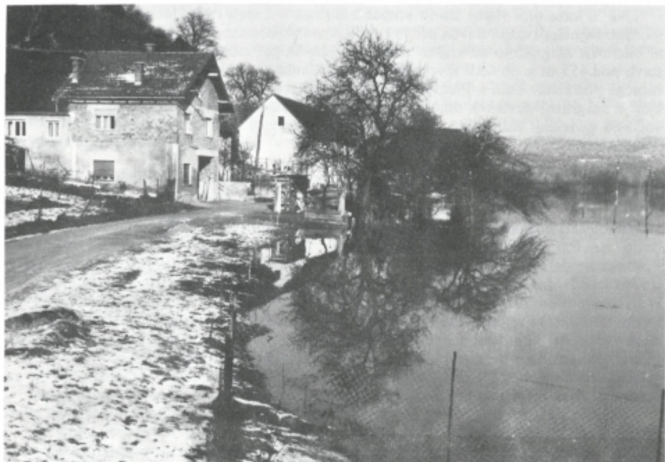
Sl. 4. Cesta v spodnji Planini poteka v n.v. okoli 450 m in je ob običajnih vsakoletnih poplavah iznad vodne gladine. Dosegajo jo srednje poplave, katastrofalne pa zalijejo tudi temelje hiše na levi strani. Nekatere domove obnavljajo v kljub ogroženosti in čeprav še ni dokončno odložen načrt za trajno vodno akumulacijo na Planinskem polju.
