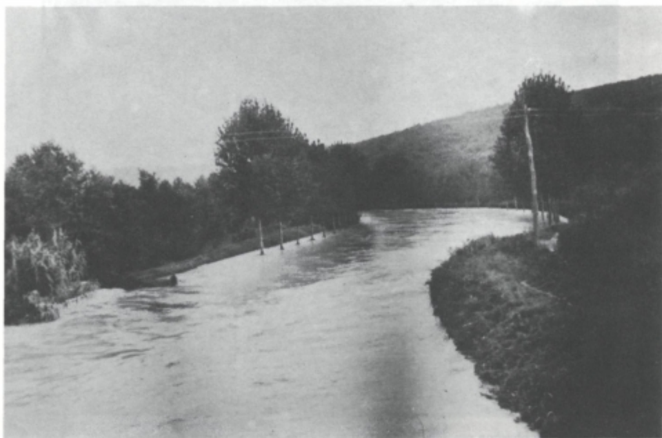
Sl. 16. Izredno visoka voda v regulirani strugi Dragonje (18. 9. 1960); na tem mestu so varovalni nasipi tudi 3–4 m dvignjeni nad zemljiščem. Na skrajni levi strani je vidno, da je voda predrla nasip ter se razlila po Ribili. (Fotografijo posredoval Ludvik P e r o š a)
