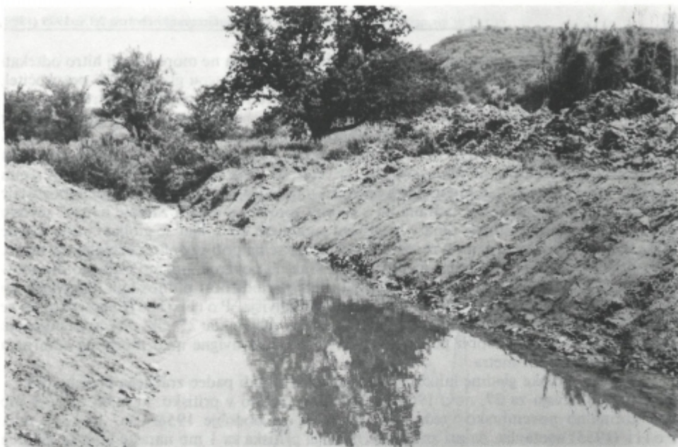
Sl. 11. Regulacijska dela na Drnici pri Pesjancih; ob vodni površini vidni prodniki holocenskega nanosa
