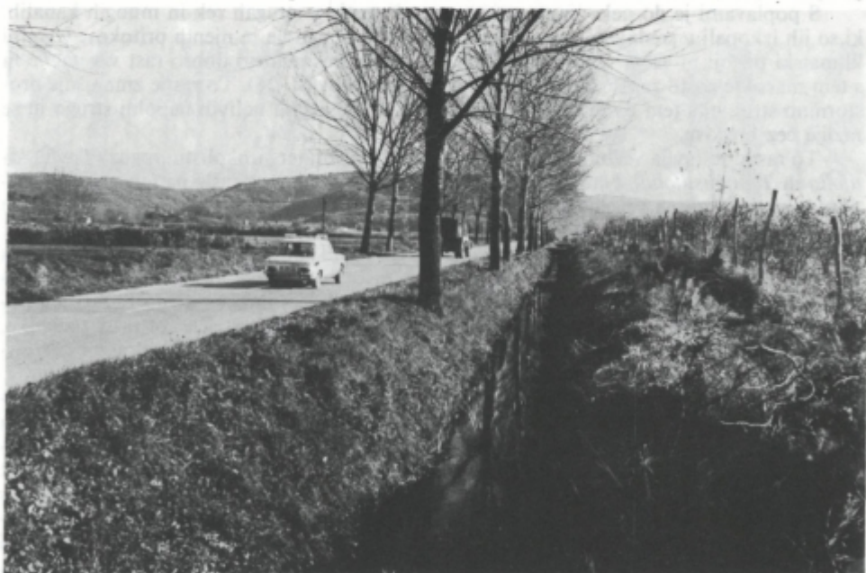
Sl. 24. Cesta preko Ribile, ki povezuje Sečovlje z naseljem Dragonja. Na obeh straneh ceste so jarki, ki odvajajo vodo v strugo stare Dragonje pri Mlinih. Cesta in ta sistem jarkov sta bila prvi ukrep za osuševanje območja že pred letom 1900
