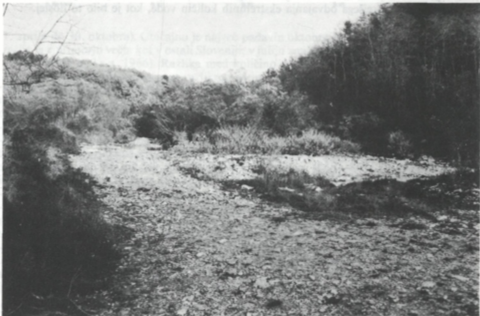
Sl. 6. Slabo oblikovana široka struga v zgornjem toku Pinjevca pod Marezigami. Ob nalivih se voda na manj širokem območju razliva na obeh straneh struge
