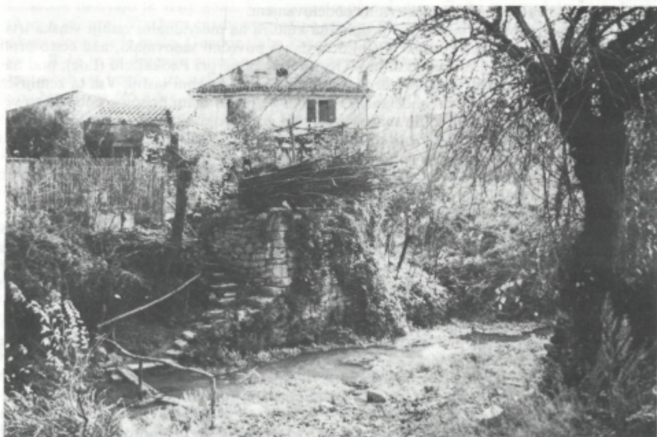
Sl. 30. Opušeni mlin ob stari Dragonji, zaselek Mlini – Sečovlje. Ob regulaciji Dragonje so tu zgradili nasip in reko povezali s kanalom Sv. Nikolaja v solinah. Stara struga reke je postala le odvodni kanal voda iz Ribile
