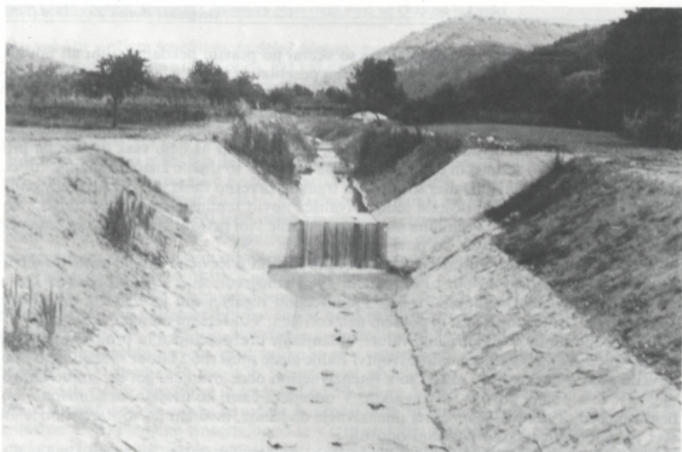
Sl. 29. Novo zgrajeni prag na Drnici pri Pesjancih (1976); tu blizu je bil mlin, ki je prenehal obratovati 1939. leta (Gregorič). V ozadju na hribu Padna
