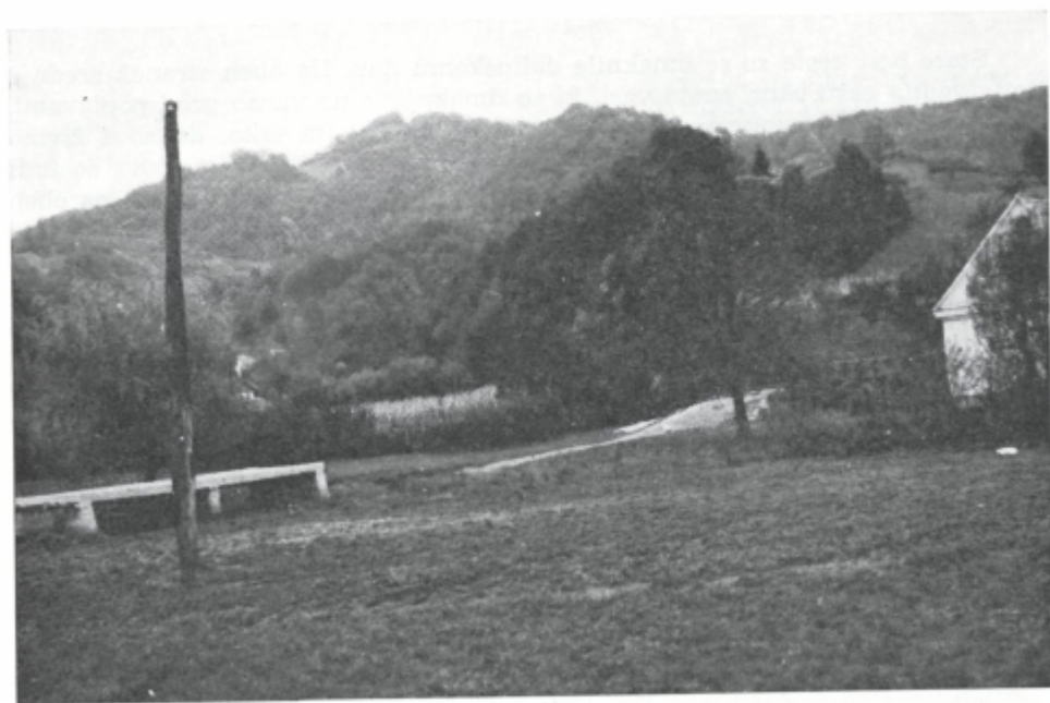
Sl. 14. Pod Vinecom. Mlin z jezom vsekakor zadržuje odtok in dviguje poplavno vodo. Danes mlina ni več, jez je v razpadu, struge nihče ne čisti. Voda redno udarja po ozki dolini. Na sliki pred poplavno vodo dvignjen most, na sredi doline pa v delu most preko poplavne vode
