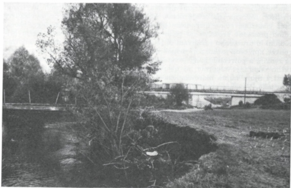
Sl. 15. Ob spodnji Bistrici pred izlivom v Sotlo pri Dobrinovem mlinu. Most v ospredju prek Bistrice, v ozadju pa že prek Sotle (železnica). Hudourniška voda Bistrice udarja prek doline naravnost v železniški most, njegova prepustnost ni dovoljna, železniški nasip zapira razlivanje vode po dolini, zato zastaja pred mostom in nasipom in trdijo, da so zdaj poplave znatnejše
