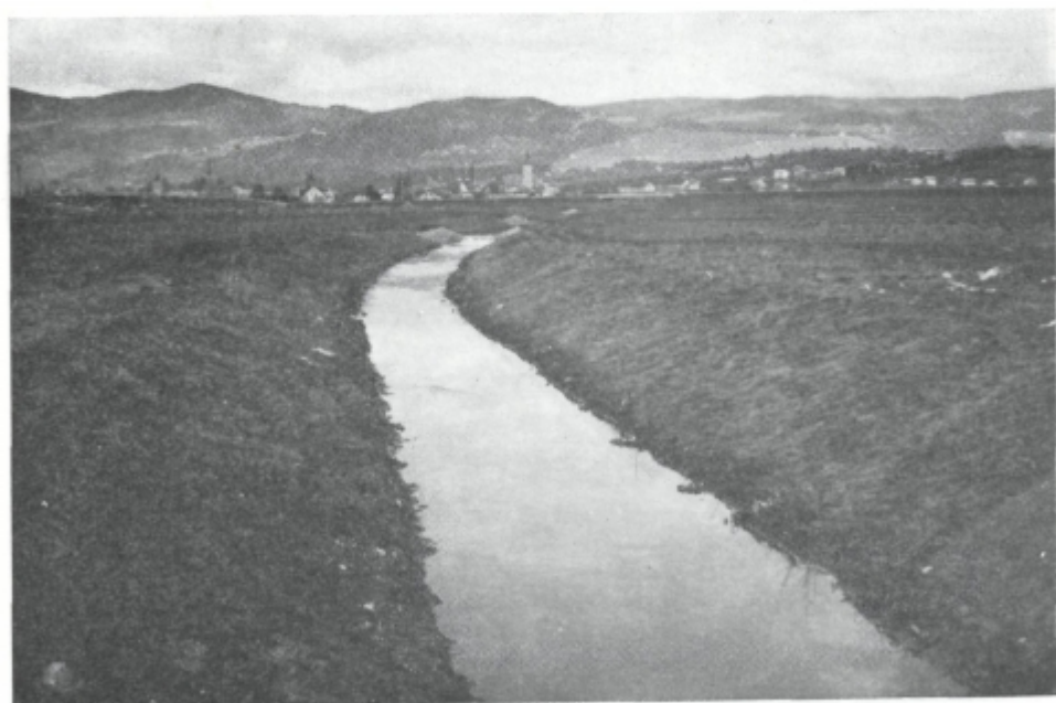
Sl. 38. Regulirana struga Ložnice nad železniško postajo v Črešnjevcu
