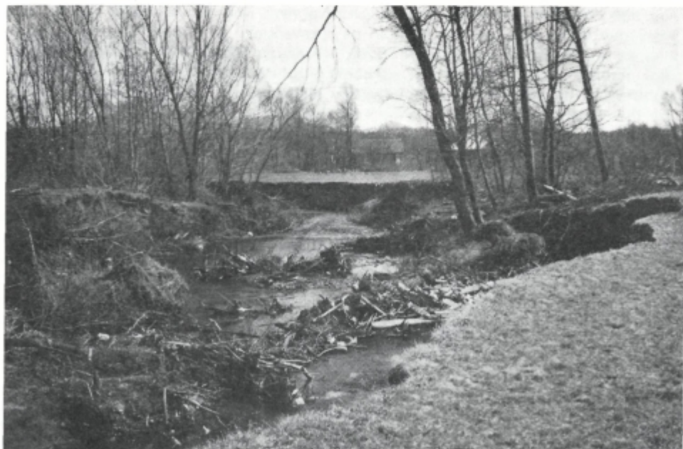
Sl. 42. Po regulaciji struge Oplotnice pod vasjo Tepanje se je v vasi Perovec, kjer reka ni regulirana, njena razdiralna moč močno povečala. Učinke prikazuje priložena slika
