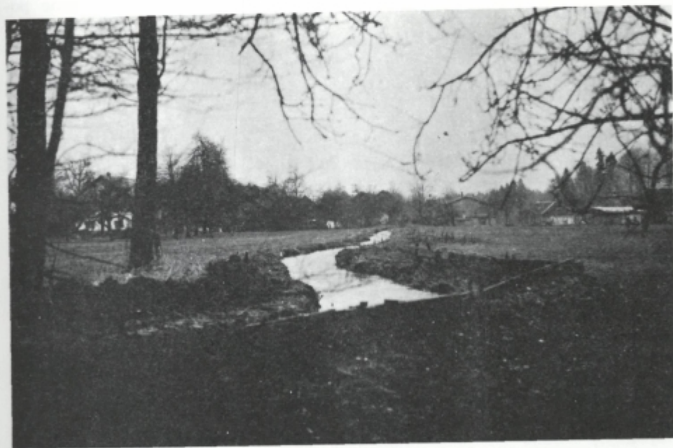
Sl. 74. Še danes z deskami in nasipi iz zemlje zavarujejo obrečne travnike pred posledicami povodnji. Pogled na zavarovani breg Reke nad Žimentovim mlinom v Nasovčah
