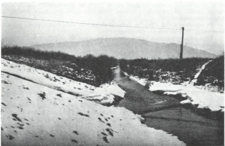
Sl. 50. Spodnji del regulacije Pšate z visokovodnim nasipom na odseku Topole - Mengeš. Na levi je odtok proti zapornici
