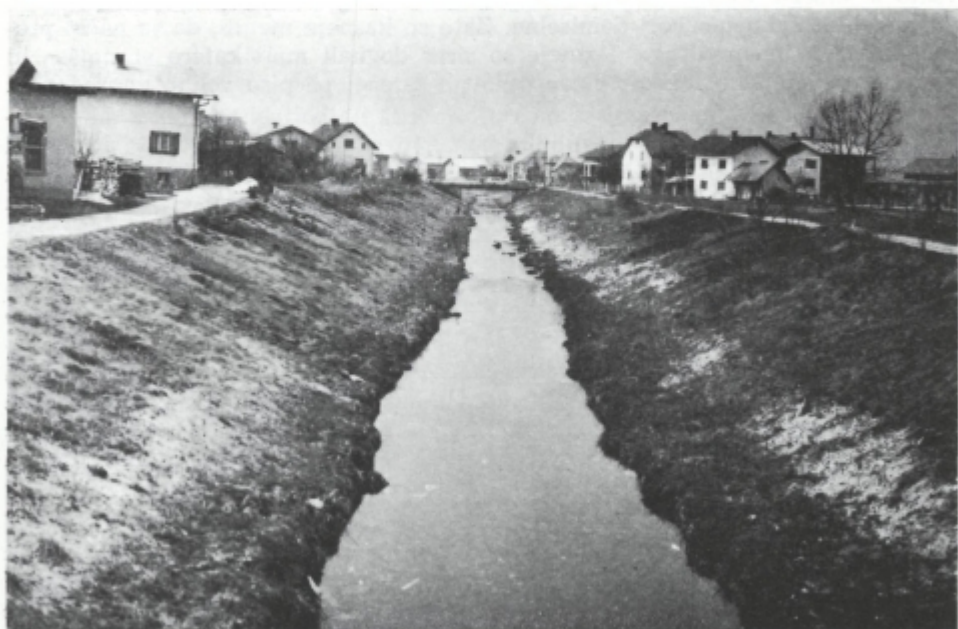
Sl. 26. Razbremenilni kanal Topole-Mengeš-Jarše, po katerem odteka visoke vode Pšate neposredno v Kamniško Bistrico. Bela proga na bregovih opozarja na destrukcijo vodnega toka. Kanal so skopali v prepustne prodne plasti, kjer je talna voda okoli 20 m globoko
