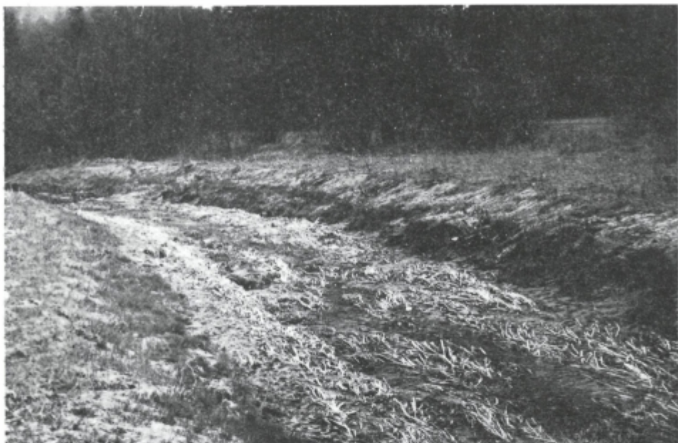
Sl. 29. Kjer je bil razbremenilnik zaraščen, je voda udarila iz kanala in preplavila travnike
