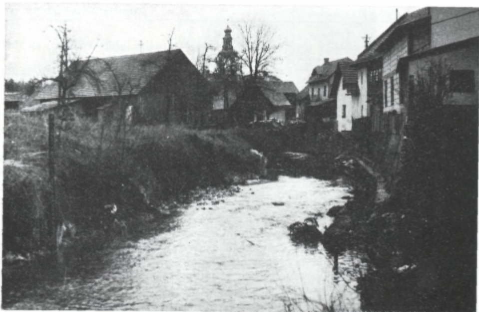
Sl. 13. Obzidana in globoka struga Pšate v Mostah. Na levi novi vodomer
