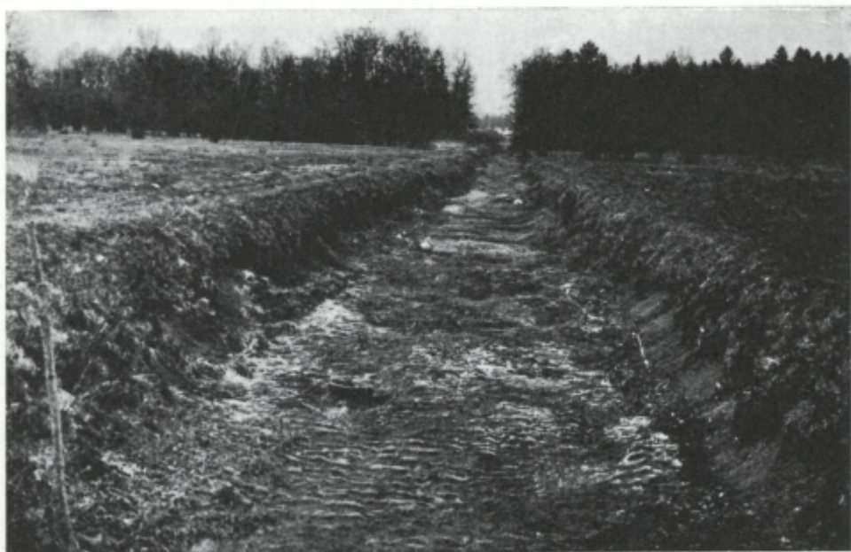
Sl. 28. V srednjem delu še novega razbremenilnika je travnata ruša že potrgana in bregovi spodjedeni
