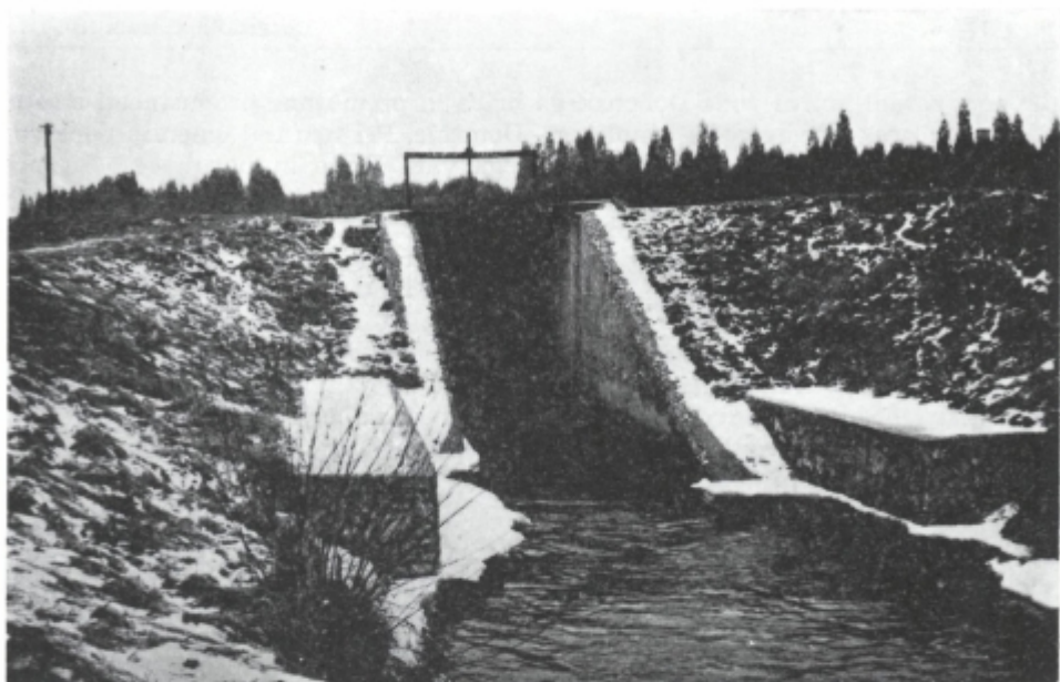
Sl. 51. Zapornica za reguliranje visokega vala Pšate. Voda je usmerjena po naravni strugi in prek razbremenilnika
