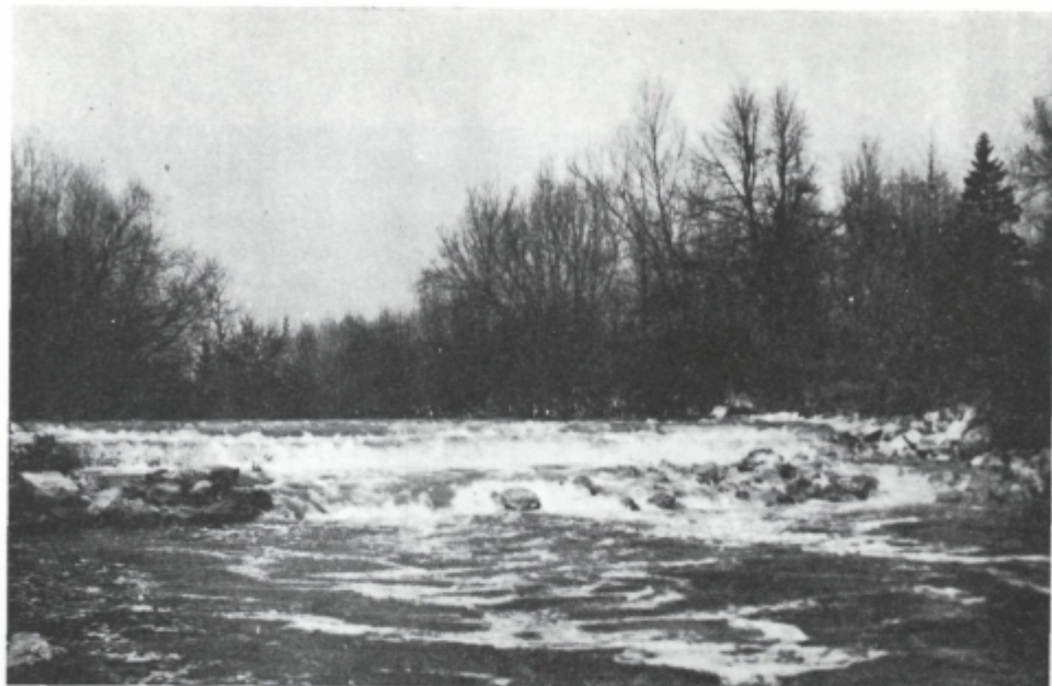
Sl. 67. S prečnimi, iz kamna zidanimi pragovi je zaustavljena oziroma zmanjšana rušilna moč Kamniške Bistrice. Ta prag, ki je danes že v razpadu, je služil tudi za preusmeritev dela Bistrice proti pšaški strugi
