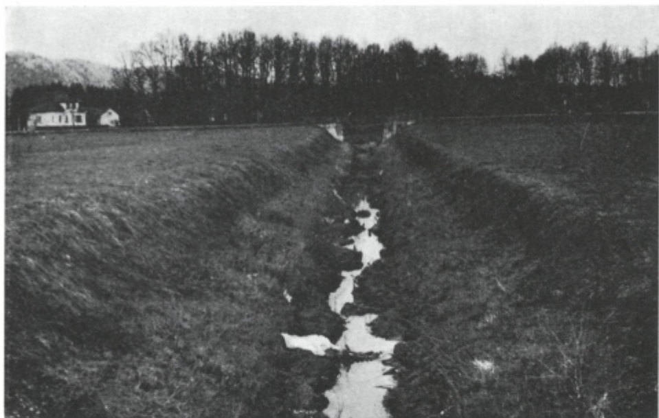
Sl. 27. Razbremenilni kanal vzhodno od Most, Suhadol in Topol so izkopali v ilovnate plasti
