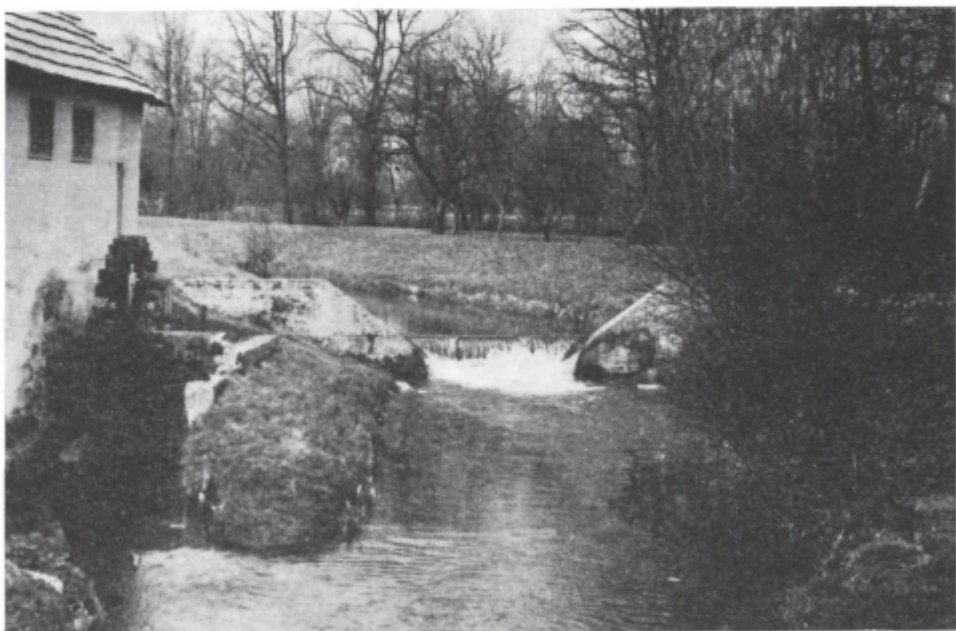
Sl. 20. Mlin v Dragomlju. Drobná energetská izraba Pšate je bila nekđaj zelo intenzivna. Na Pšati in njenih pritokih je bilo nad 50 mlinov in žag. Jezovi so poplave stopnjevali
