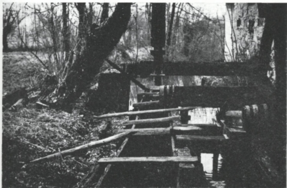
Sl. 62. Nekoč so mlinarji in žagarji največ skrbeli za vsakoletno čiščenje in urejevanje mlinščic, s čimer je bila zmanjšana možnost poplav. Rake Jurjevega mlina ob Pšati v naselju Pšata
