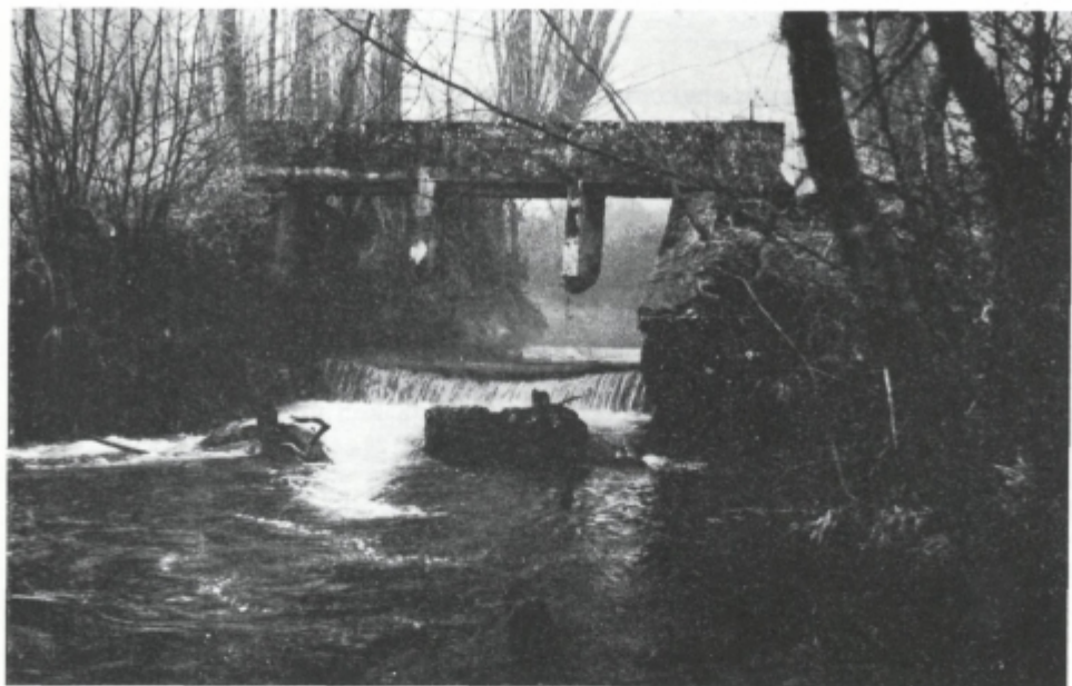
Sl. 65. S propadom obrtnih dejavnosti na vodni pogon so tudi jezovi izgubili svojo nekdanjo, nadvse pomembno veljavnost pri urejanju vodnega stanja. Gmajnarjev jez na Pšati pri naselju Klanec
