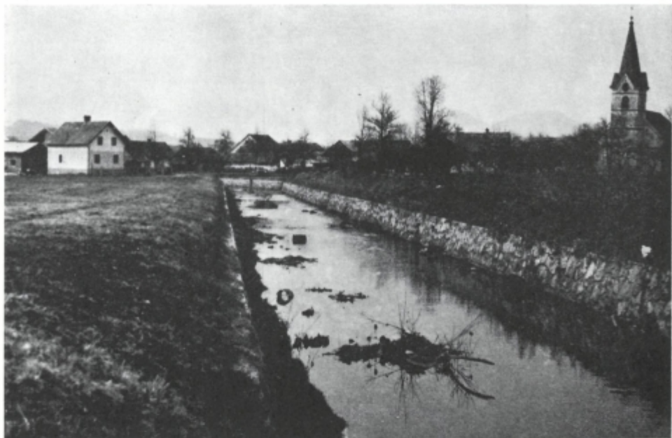
Sl. 23. Suhadole niso več na udaru poplavnega vala, odkar so z novo strugo presekali zavoj sredi vasi
