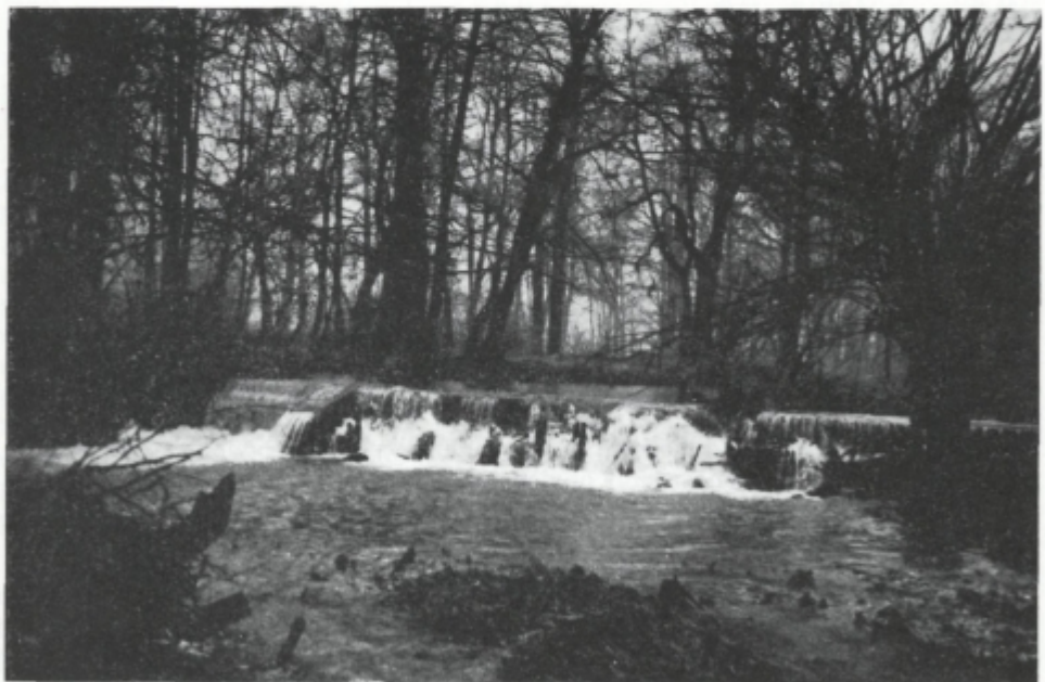
Sl. 66. S številnimi jezovi je bilo regulirano vodno stanje skoraj na vsej dolžini naših potokov. Opuščeni in propadu zapisani jez na Pšati; za njim se končuje nekaj sto metrov dolgi kanal, ki je »hranil« Pšato z vodo iz Kamniške Bistrice
