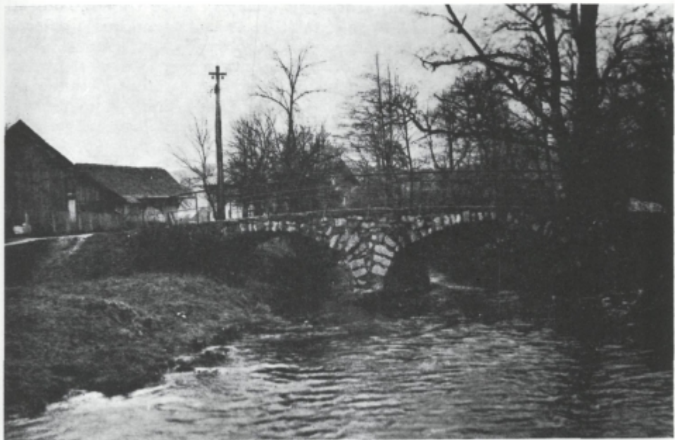
Sl. 80. Ob hudih povodnjih se je zgodilo, da je bila propustnost mostu premajhna, kar je povzročilo obsežne poplave v južnem delu naselja Loka. Slika kaže domnevno srednjeveški most prek Pšate v Loki pri Mengšu
