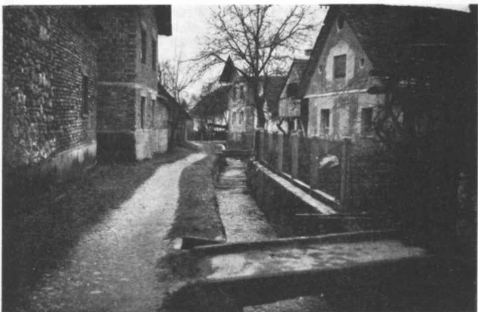
Sl. 70. »Suhi graben« (tj. levi krak) Reke v Cerkljah je povečini urejen. Njegove brežine so zavarovane z betonsko škarko
