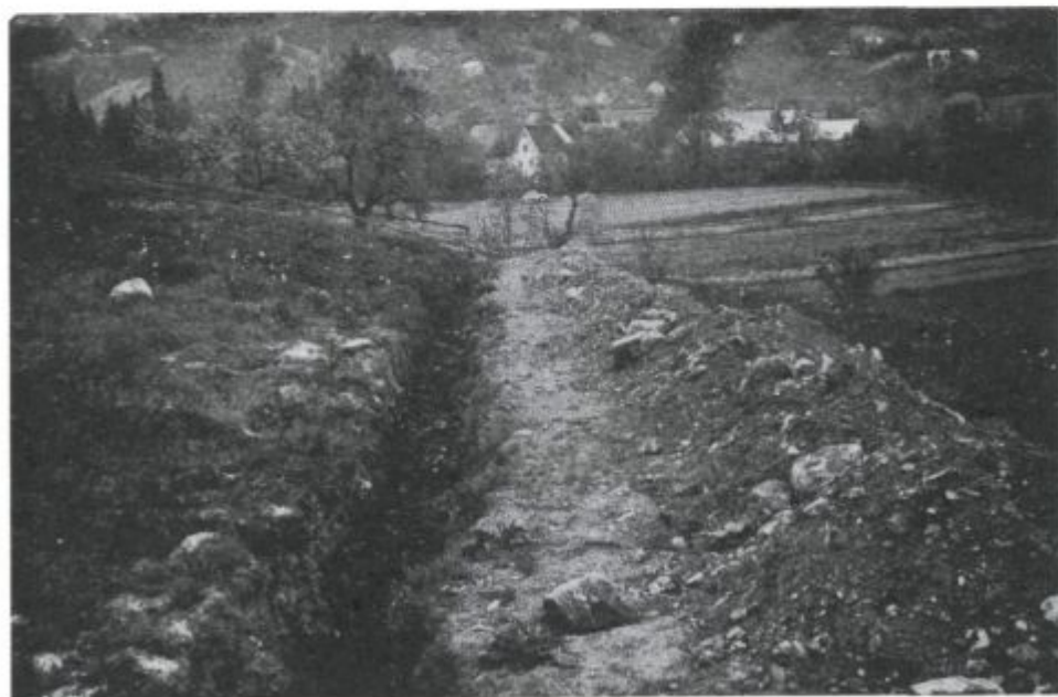
Sl. 30. V jarkih za vodovod v Rodani vasi (terasa 2) je bila poleg proda, ki ga vidimo na sliki, razkrita tudi terciarna živoskalna podlaga
