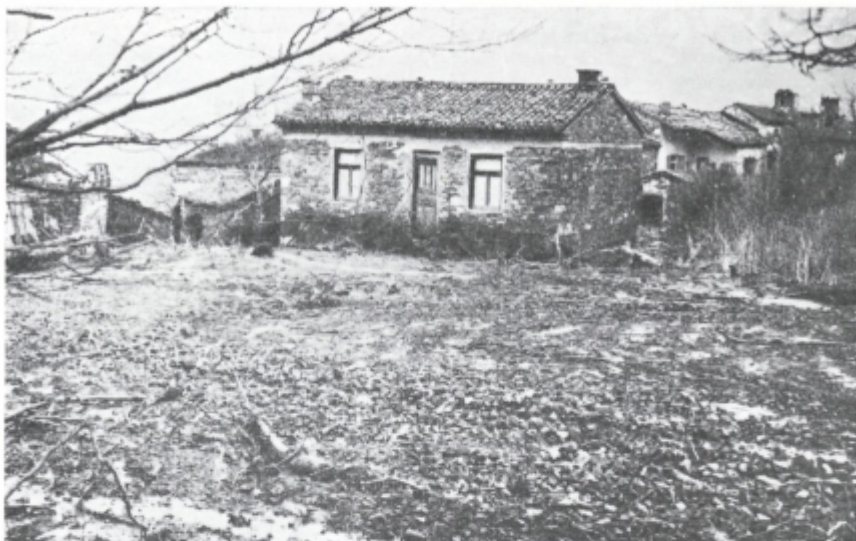
Sl. 21. Spodnji konec zemeljskega plazu, ki je pritisnil ob prve hiše v Podragi. Hišo v srednjem delu slike je zatrpal do polovice. Nad nanosom je le nadstropni del hiše. Plaz sega neposredno do balkonskih vrat
