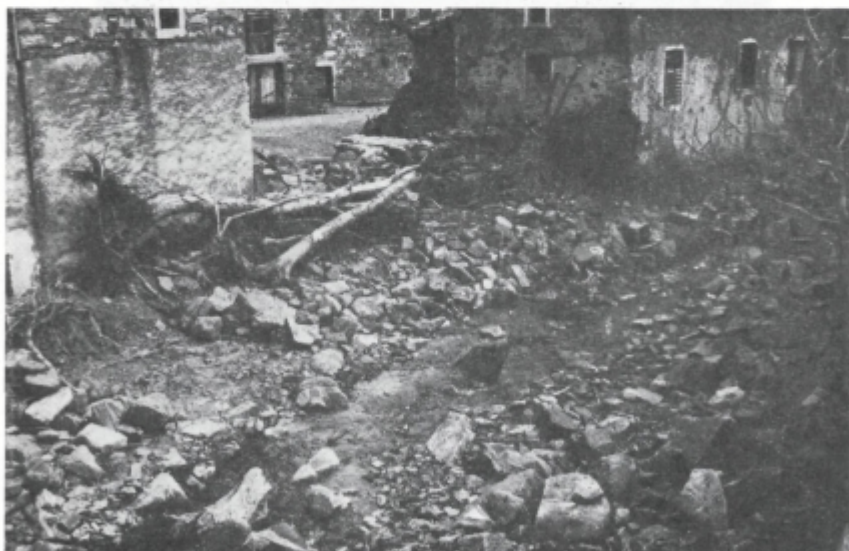
Sl. 27. Do 2 m visoko zasuta struga Mrzlega potoka med hišami v Podragi. Grobo kameninsko gradivo in izrjavana drevesa pričajo o silovitosti vodnega toka
