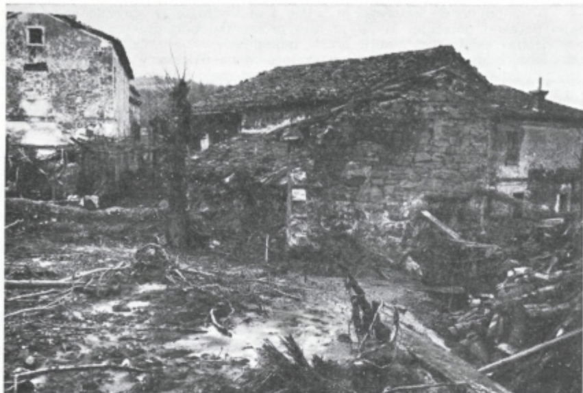
Sl. 24. Porušena hiša na čelni strani plazu. Čeprav je zidana, ni zdržala pritiska blatnih gnot, ki so pritiskale ob hišo s težo več ton na kvadratni meter
