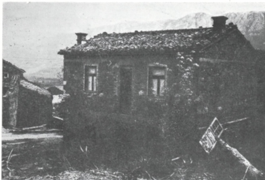
Sl. 22. Ista slika kot na prejšnji sliki; medtem so jo že odkopali
