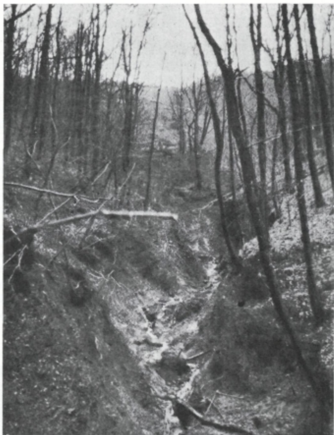
Sl. 19. Razmehčane gmote na koncu usada so udarile po grapi navzdol in ustvarile plazino. Pri tem so potrgale drevje in kameninsko gradivo ter ga nosile s seboj
