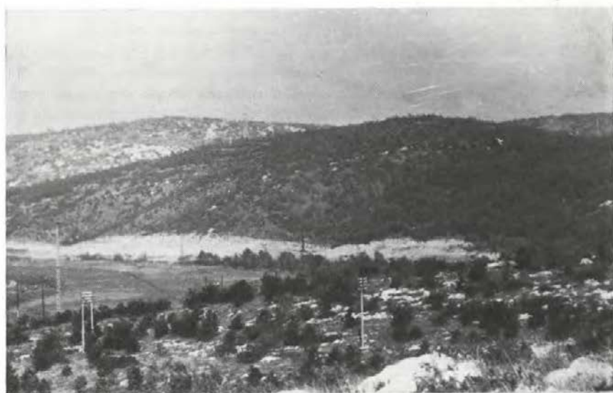
Sl. 24. Po Selškem kraškem dolu so nedavno zgradili avtomobilsko cesto. Vseki ob vznožju skalnih pobočij so v korodiranem apnencu razkrili ostanke stare fluvialne akumulacije, ponajveč kremenovega proda. Na sliki gradnja ceste pri Sabličih 1965. leta
