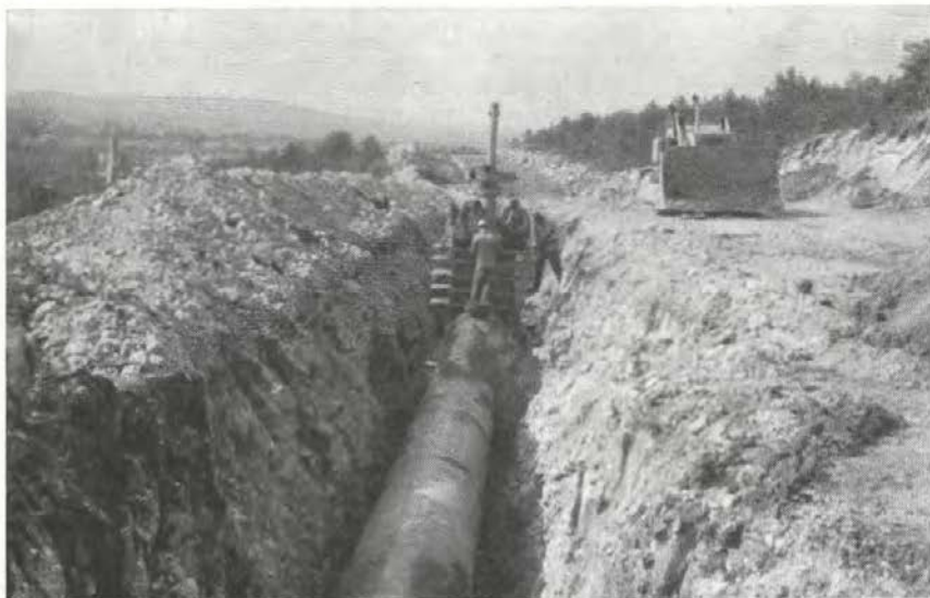
Sl. 11. Gradnja naftovoda preko Doberdobskega Krasa. Jarek, ki so ga v ta namen skopali, je nudil profil, ki je bil za študij korozijskih in drugih procesov ter njihovih oblik v površinskih delih apniškega sveta zelo dragocen. Ob jarku se je dalo lepo zasledovati tudi infiltracijo kraške ilovice in fluvialnega gradiva v apniških tleh. Posebno lepo pa se je dalo ugotavljati stopnjo in obliko infiltracije v zvezi s petrografske oziroma skladovno sestavo tal ter drobno korozijsko razčlenjenostjo apniškega površja
