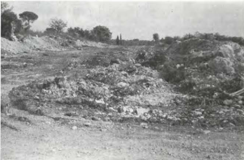
Sl. 12. Po izkopu in napeljavi cevi je ostala široka proga razritega površja, ki se vleče na Doberdobskem Krasu vzdolž vsega južnega in zahodnega roba okoli 12 km daleč. Razrito površje je nudilo dober vpogled tudi v pedološkem smislu
