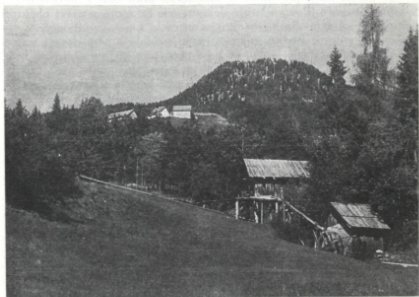
Slika 8. Iz zbirne vodne jame na nivojnem ostanku pri Žibovtu (1100 m) je speljana voda po cevi na turbino, ki žene elektrarno, žago in mlin pa žene potočna voda. Kmetija zadaj je Covník (1215 m) in za njo Veliki Vrh, sestavljen iz trdih devonskih koralnih apnencev
