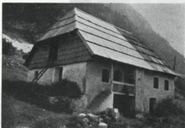
Sl. 7. Značilna soška hiša, stoji v bregu, je vrhhlevna in ima veliko podstrešje. Spodaj sta hlev in klet, nad tema kuhinja, hiša in dve kamri. Ostrešje je visoko, streha krita s škodlami
