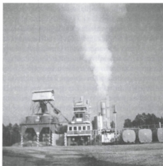
Asfaltarna Velika Pirešica (foto A. Lah)
