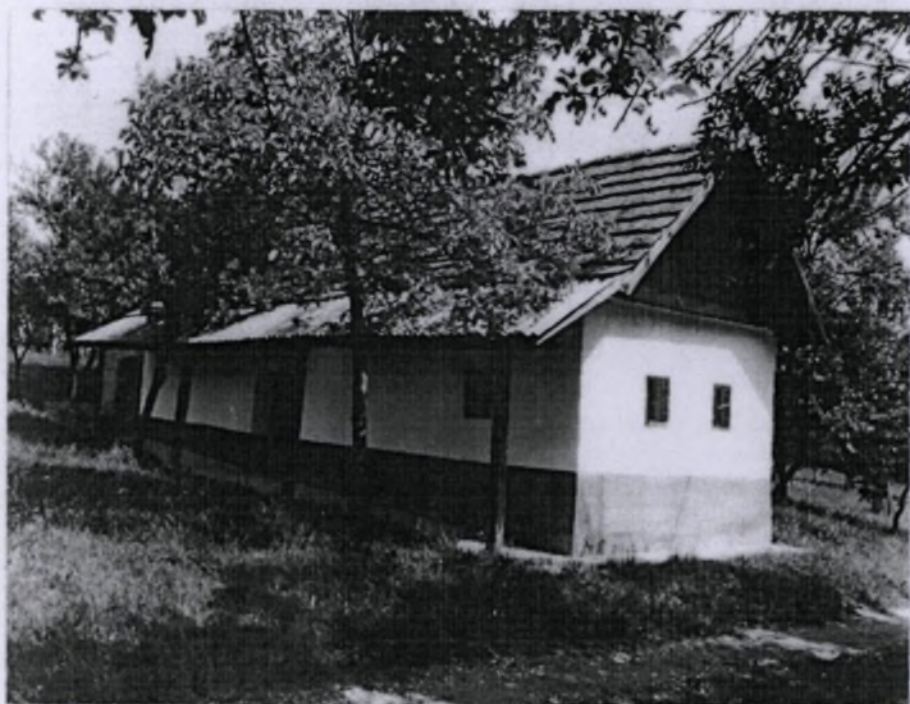
Primer relativno posrečeno obnovljenega objekta na Ovsišču, ki pa ga kazi vpadljiv salonitni nadstrešek.
