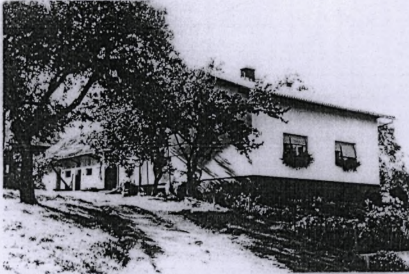
novogradnja, ki ne povzema meril prekmurske hiše
