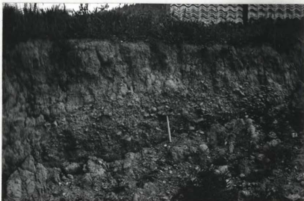
Sl. 28 Pri izkopu temeljev za nove hiše v vasi Zaklanec so razkrili v vršaju poleg ilovic tudi prod.
