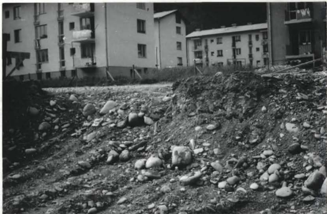
9 Sl.13 Slika prikazuje debel in lepo zaobljen prod, ki so ga razkrili v vršaju Češnjice pri izkopu temeljev za številne nove stanovanjske hiše.
