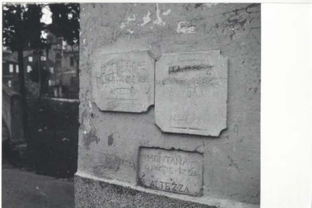
Sl. 17. Plošče, ki označujejo ekstremne višine poplavne vode, vzdane na hiši /trgovina/ ob stari strugi Dragonje v Sečovljah. Spodnja plošča označuje višino vode, ki je bila 9. oktobra 1765, zgornja desna 10 - 11. 10. 1852 in zgornja leva 14. 10. 1896. Ob vseh teh dogodkih so bile poplavljenе celotne Sečoveljske soline.
