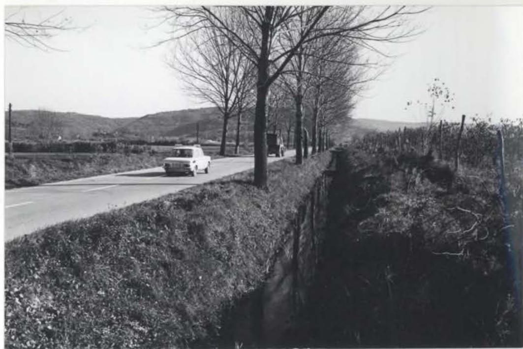
Sl. 24. Cesta preko Ribile, ki povezuje Sečovlje z naseljem Dragonja. Na obeh straneh ceste so odvodni jarki, ki odvajajo vođo v strugo stare Dragonje pri Mlinih. Cesta in ta sistem jarkov je bil prvi poseg v osuševanju območja že pred letom 1900.
