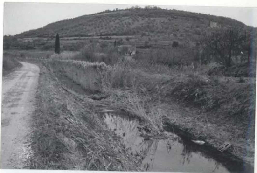
Sl. 25. Struga Drnice pod Sv. Onofrijem. Rečne struge in odvodne kanale stalno zarašča kanela - trsje in je potrebno skrbno čiščenje, da ne bi ovirale odtok vode. Kanelo uporabljajo za oporo stročnicam in v vinogradih.
