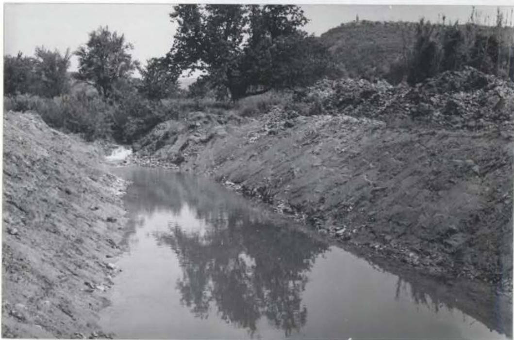
Sl. 11. Regulacijska dela na Drnici pri Pesjancih ob vodni površini videni prodniki holocenskega nanosa.
