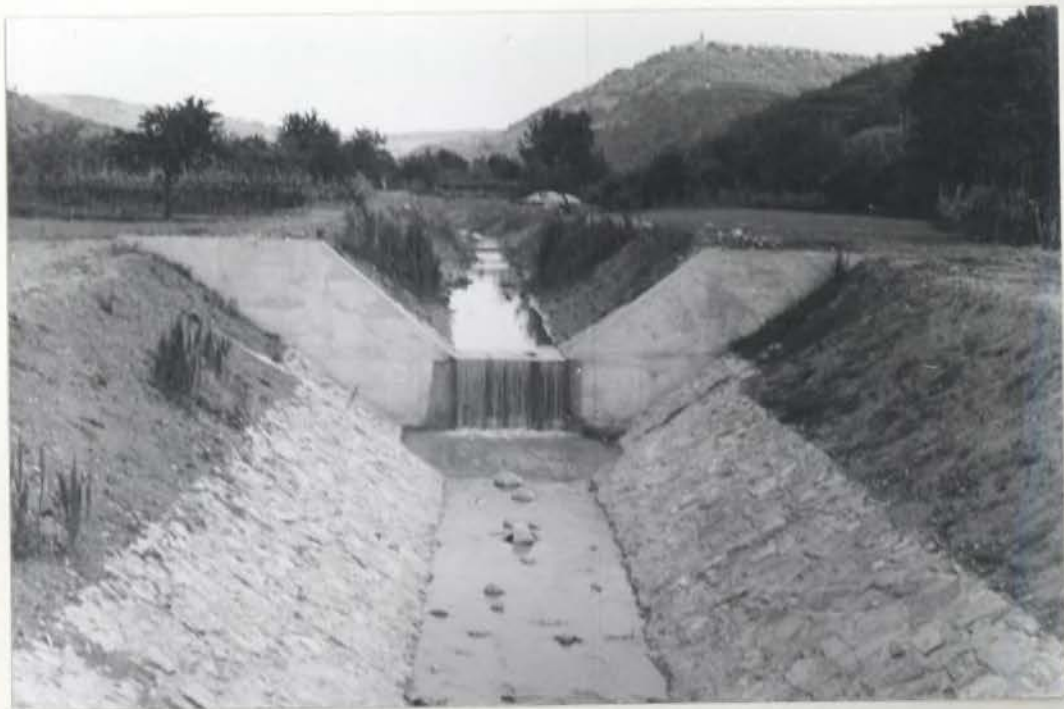
Sl. 29. Novo zgrajen prag na Drnici pri Pesjancih /1976/ tu v bližini je bil mlin, ki je prenehal obrato- vati 1939 leta /Gregorič/. V ozadju na hribu Padna.
