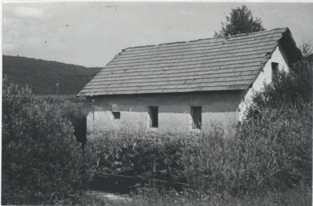
Sl. 35. Opuščen Vrbetov mlin na Sici.
