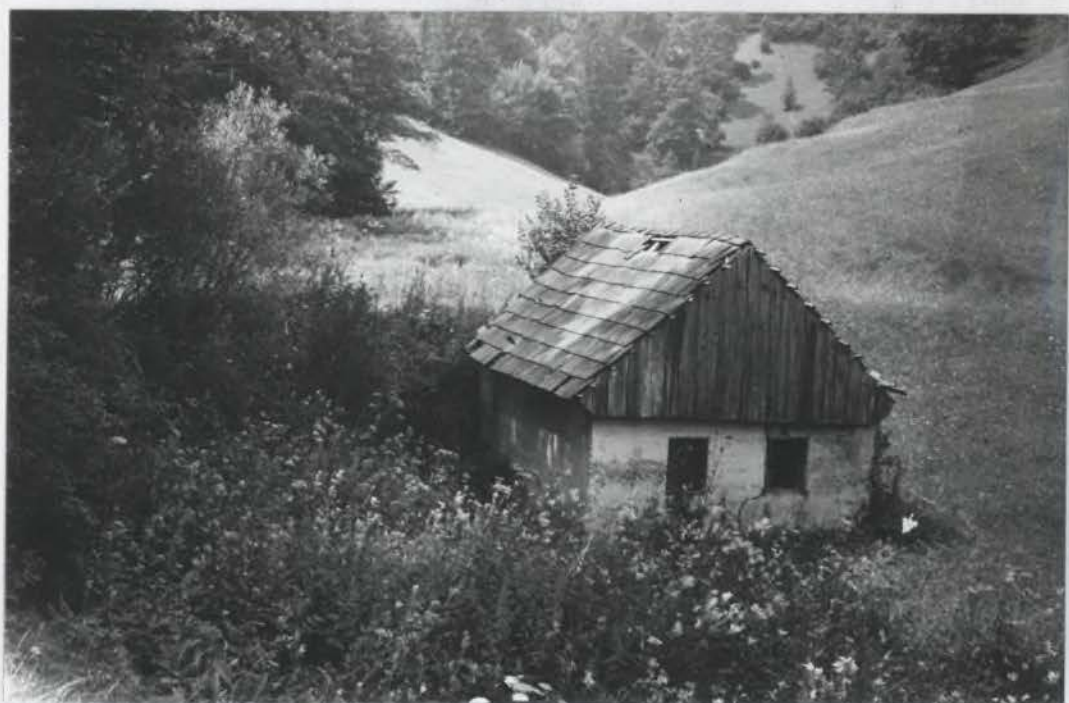
Sl. 38. Opuščen mlin v mokrotnem dolinskem dnu Podkamna severovzhodno od Malih Lipljen.
