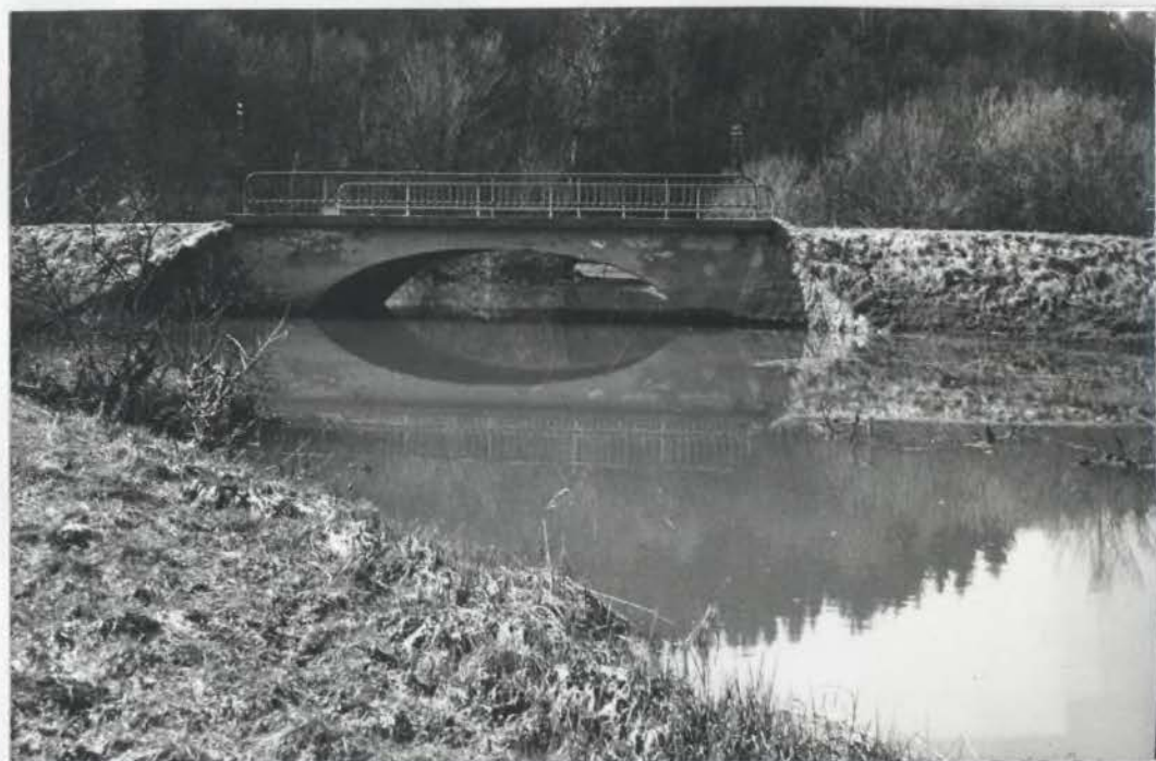
Sl. 27. Obseg pogostne srednje poplave ob mostu čez Dobravko jugozahodno od Boštanj; voda zalije približno 2/3 mostnega propusta.
