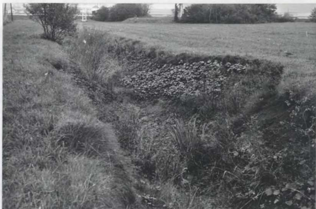
Sl. 29. Ugrez v jarku niže od Malenskega mlina v aluvialni ravnici Grosupeljščice-Dobravke.
