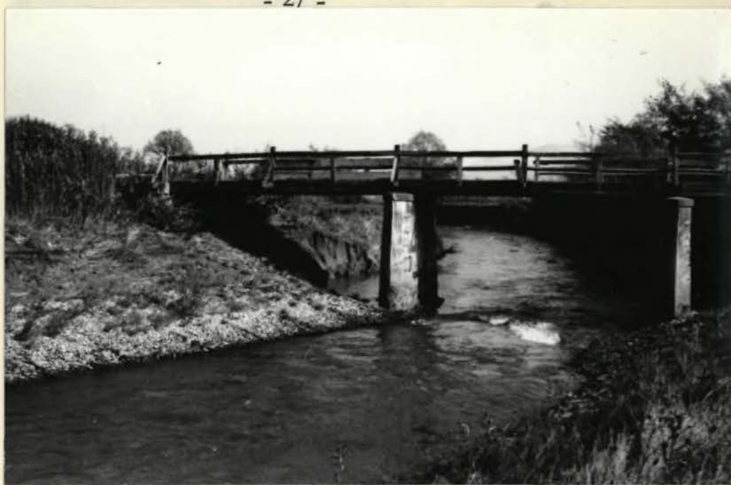
Slika 9 : Most ob srednji Sotli. Piloti ožijo strugo, povečujejo hitrost in erozijsko moč narasle vode, ki spodjedajo bregove.
