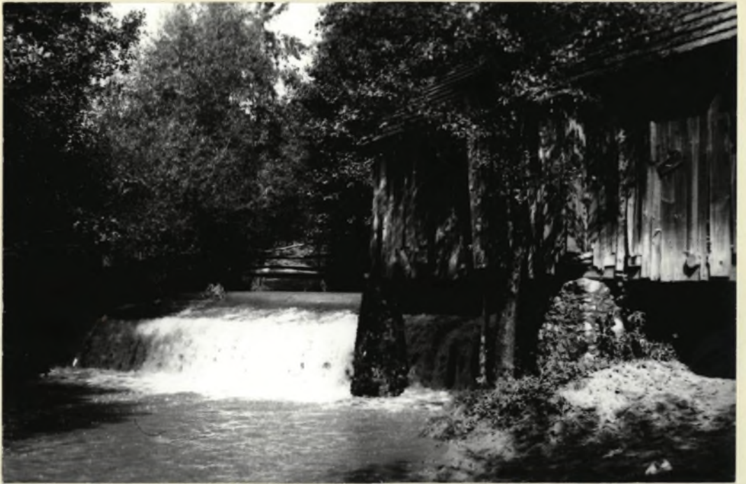
Slika 13: Lohova žaga in jez ob spodnjem Tinskem potoku, zdaj brez funkcije.
