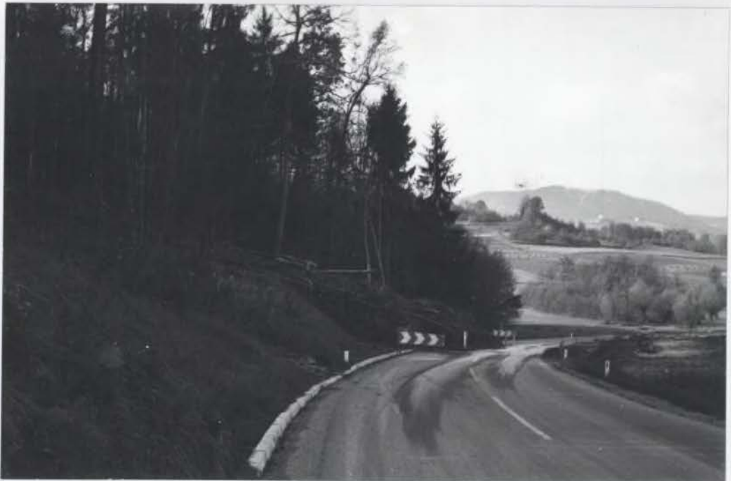
Sl. 18. Zemeljski plaz povzročil zaporo ceste Dekmarca-Srebernik.
