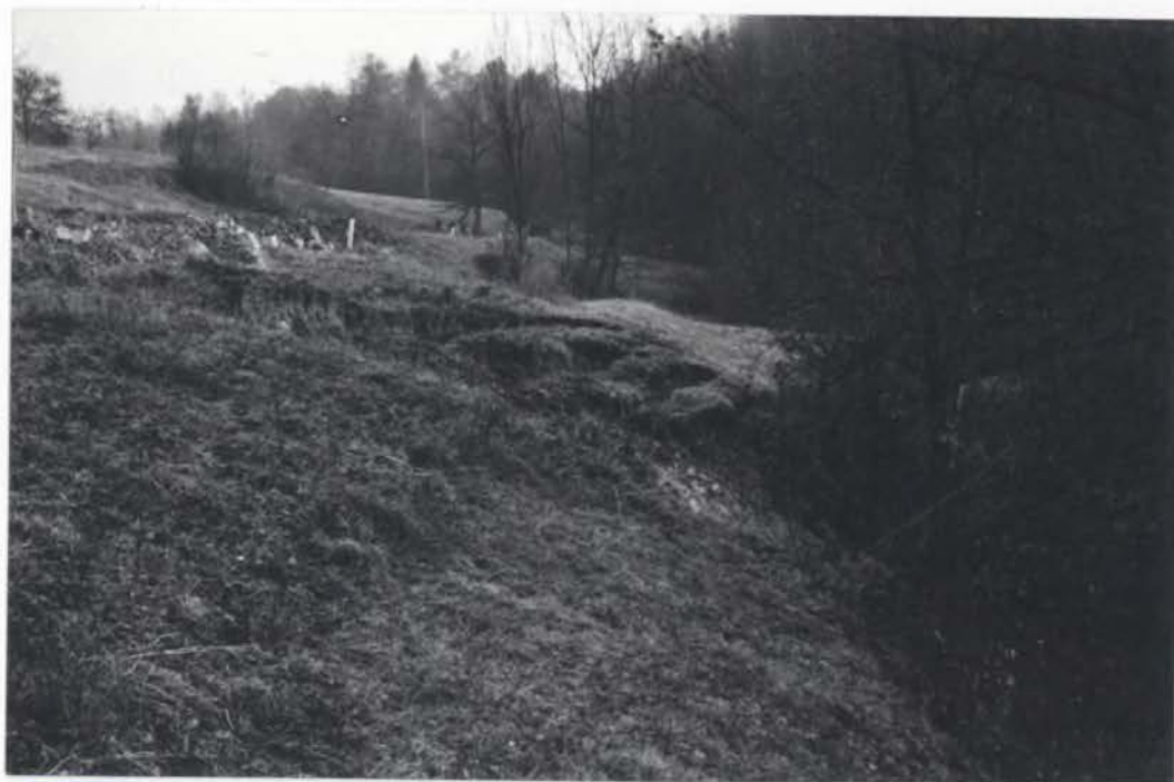
Sl. 19. Izpodjedanje in bočno trganje brežin p. Sušice je bilo vzrok usadu, ki je poškodoval cesto Pilštanj-Golobinjek cca 2,5 km nad Pilštanjem in zgrmel direktno v strugo potoka.
