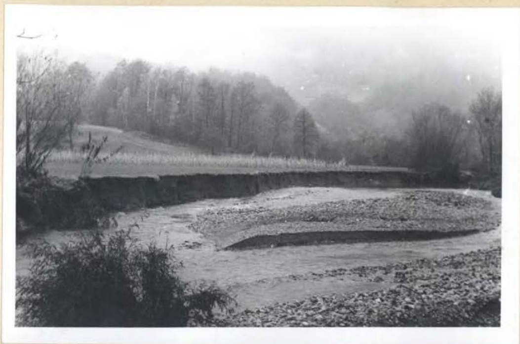
Sl.9 Bočna erozija p. Bistrice pred Podsredo in večja deponija erodibilnega materiala.
