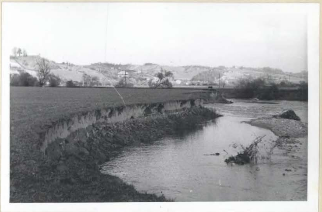
Sl. 4 Tok Sotle na Kumrovškem polju. Bočna erozija neprestano širi strugo, kar omogoča veliko propustnost.
