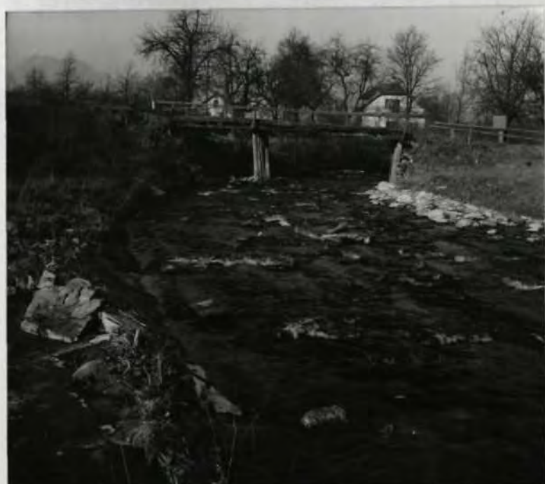
Fot. 4 - Mislinja pred Smonkarjevim mostom /Mislinjska Dobrova/. Odkar je više propadlo več jezov, tudi regulacija ni preprečila lokalne akumulacije prod. Za pol metra s prodniki zvišano dno je zasulo kanal do hidrografa /desno od mostu/, ki ne dela več.
