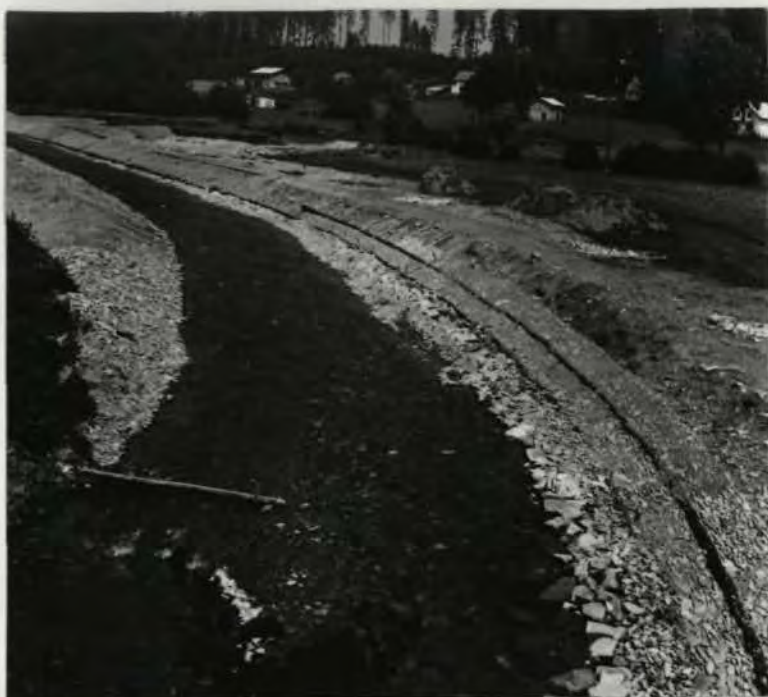
Fot. 5 - Mislinja med Trebuško vasjo /Šmartno/ in Slovenj Gradcem. V zgornjem desnem kotu je pod levo hišo opazna stara struga, ki zavija pod breg legenske terase. Pod bregom je bila reka že pred leti regulirana, a je povodenj 1973 drago regulacijo v začetnem delu porušila in se je ni več splačalo popravljati. Tak način utrjevanja bregov, kot je viden na fotografiji pri sveži regulaciji, je ob Mislinji običajen.
