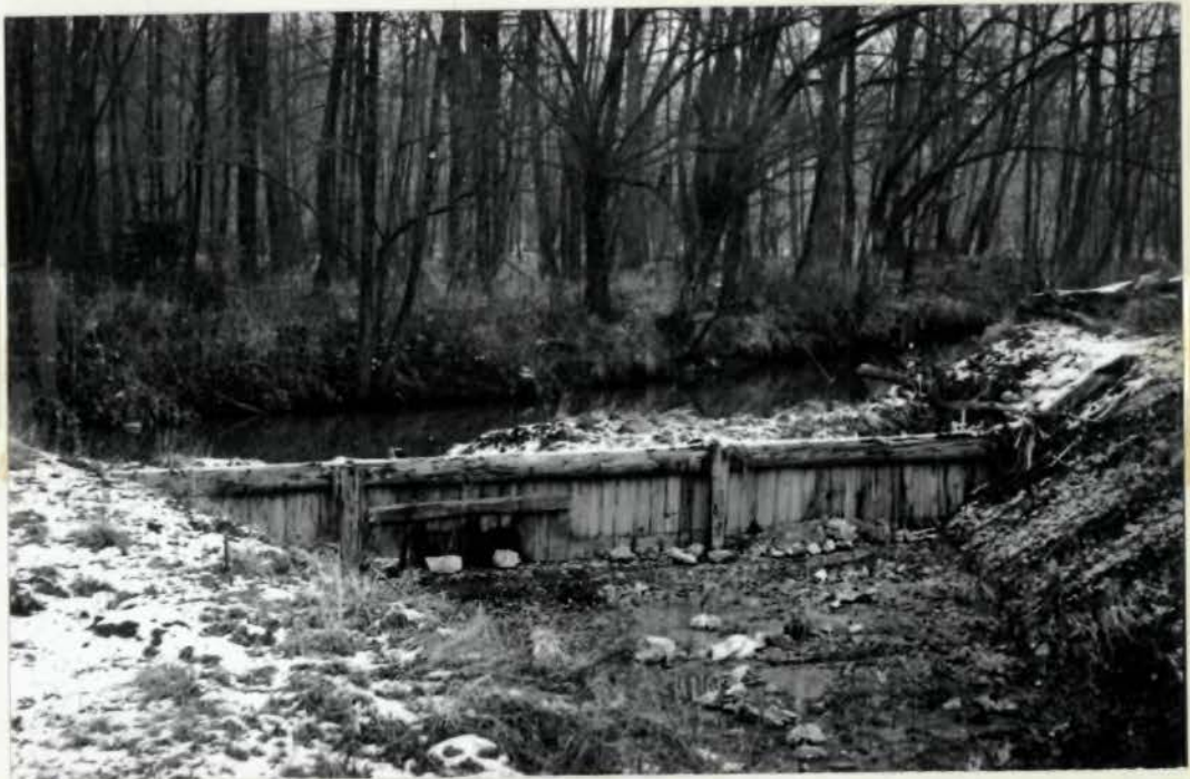
Sl. 8. Talni prag (pregrada) na začetku razbremenilnika Moste-Stržen.
