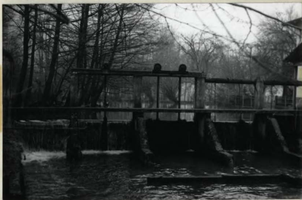
Sl. 4 Merčunov jez na Pšati (v naselju Pšata) še danes služi svojemu namenu. Akumulirana voda pada na vodno turbino, ki poganja "Felixsov" valjčni mlin.
