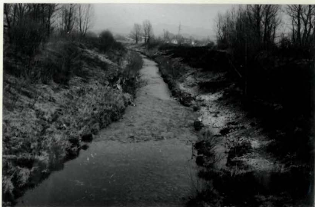
Sl. 30 Erozijsko razdiranje razbremenilnega kanala.
