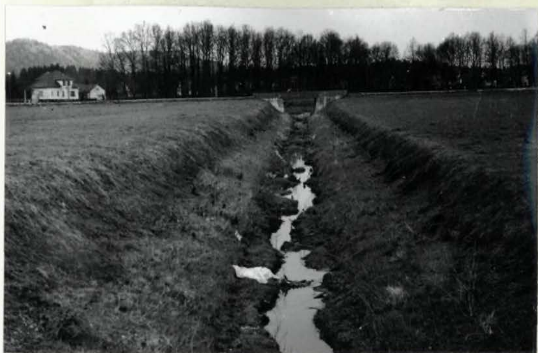
Sl. 31 Razbremenilni kanal vzhodno od Most, Suhadol in Topol so skopali v ilovnate plasti.
