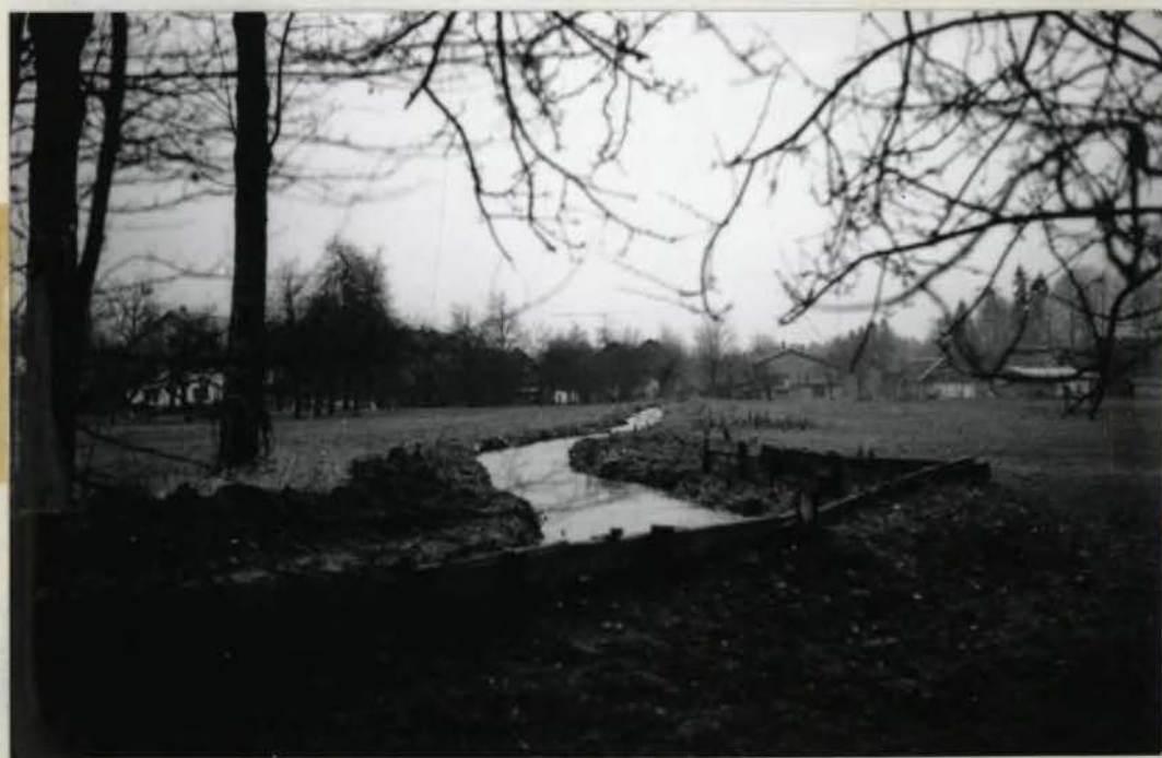
Sl. 18 Še danes z deskami in nasipi iz zemlje zavarujejo obrečne travnike pred posledicami povodnji. Pogled na zavarovani breg Reke nad Žimentovim mlinom v Hasovčah.
