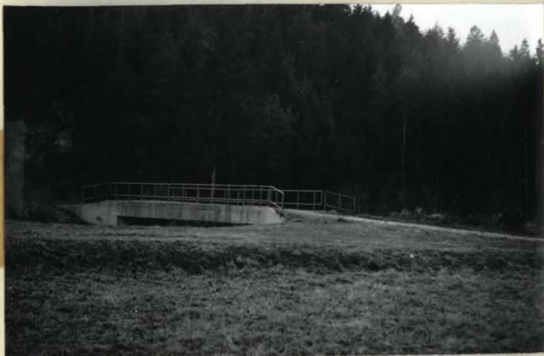
Sl. 29 Drevje in grmovje ščitita breg pred razdiralno močjo potočne vode. Z vrkami zavarovani breg Pšate v Slevcu pod Suhadolami.
