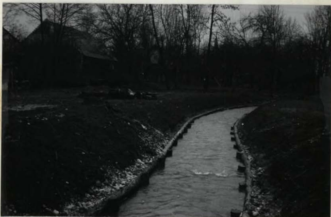
Sl. 12 Še danes človek tu in tam dejavno posega v urejevanje in čiščenje rečnih korit. Pogled na novo urejeno strugo Reke v Zgornjem Brniku.
