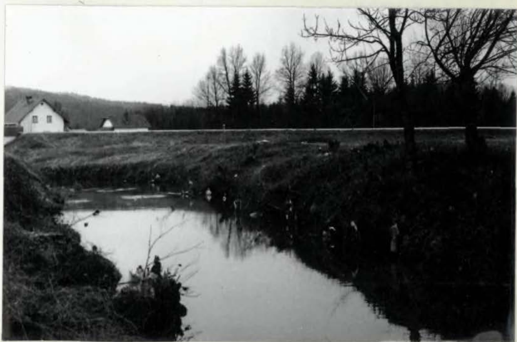
Sl. 18 Nasip s cesto, ki prečka Pšato, se ob poplavih spremeni v jez, ob katerem se poplavna voda na široko razlije.
