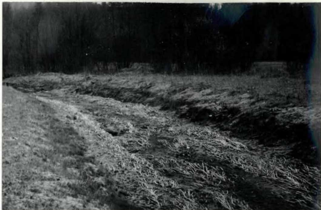
Sl. 33 Kjer je bil rasbremenilnik zarašččen, je voda udarila iz kanala in preplavila travnike
