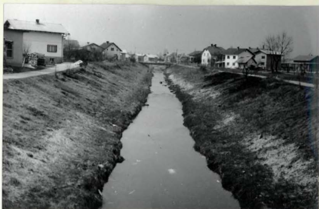
Sl. 29 Razbremenilni kanal Topole-Mengeš+Jarše po katerem odteka visoke vode Pšate neposredno v K. Bistrico. Bela proga na bregovih opozarja na destrukcijo vodnega toka. Kanal so skopali v prepustne prodne plasti, kjer je talna voda okoli 20 m globoka.
