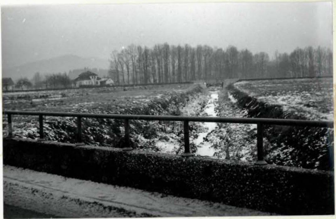
Sl. 7. Pogled na razbremenilnik Moste-Stržen.
