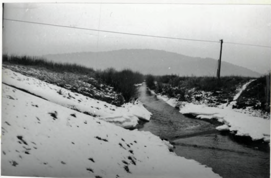
Sl. 2. Spodnji del regulacije Pčate z visokovodnim nasipom na odseku Topole-Mengeš. Na levi je odtok proti zapornici.
