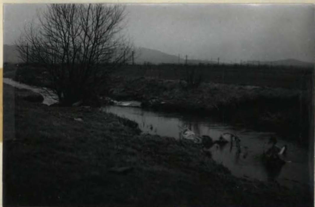
Sl. 22 Že najmanjša ovira v dnu korita lahko preusmeri udarno moč vodnega toka. Voda je pričela razjedati ne dovolj utrjeni in nezavarovani desni breg Pšate (pod Trzinom).
