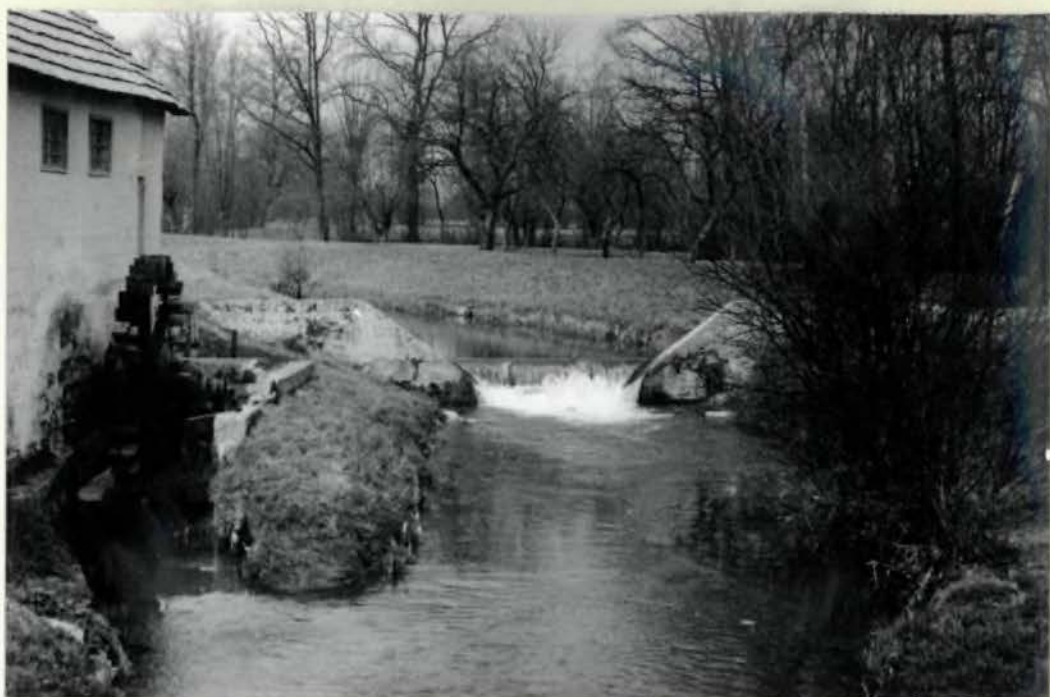
Sl. 23 Mlin v Dragomlju. Drobna energetska izraba Pšate je bila nekdanj zelo intenzivna. Na Pšati in njenih pritokih je bilo nad 50 mlinov in žag. Jezovi so poplave stopnjevali.
