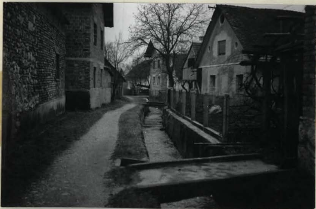
Sl. 26 Cestišča večine novih mostov so vidno dvignjena nad okoliško ravnico. S tem je povečana njihova propustnost v času visokih voda. Most na Pšati nad Mlinarjevo domačijo v Topolah.
