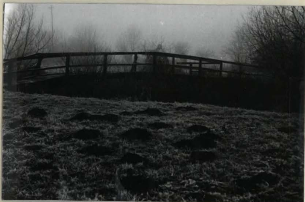
Sl. 32 Po izkopu razbremenilnika Kaplja vas - Stržen povodenj ne prizadene več travnikov v "Senežetih". Na njih pa se še vedno zadržuje deževnica, ki povzroča "mile poplave".
