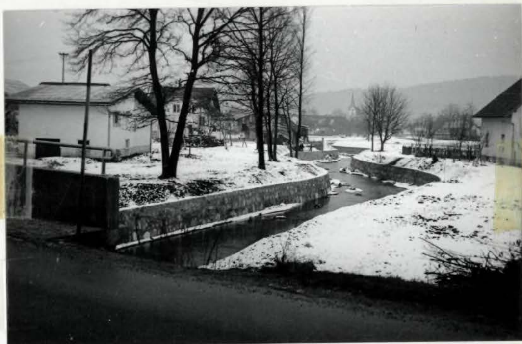
Sl. 10. Regulacija Pšate nad cesto Moste-Brnik.
