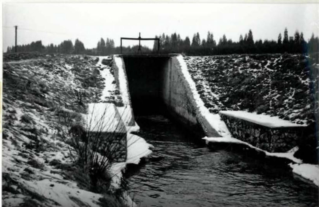
Sl. 3. Zapornica za reguliranje visokega vala Pšate. Voda je namerjena po naravni strugi in preko razbremenilnika.
