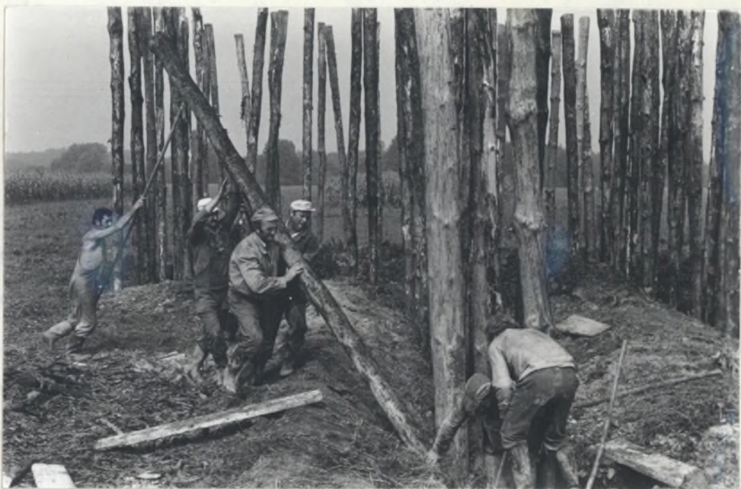
Sl. 15. Postavljanje pilotov za temelje nove hiše na Barju. Foto Milan Orožen Adamič.
