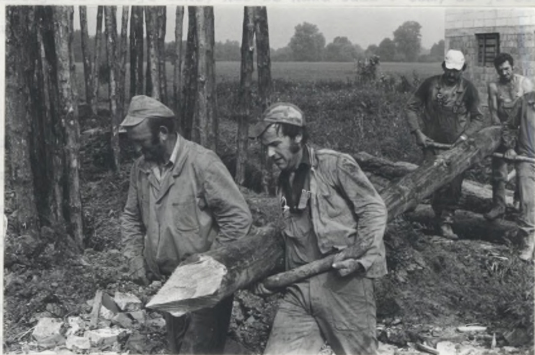
Sl.16. Na meter temeljev postavijo približno 3 pilote, ki jih zabijejo v zemljo na roko ali z bagerjem. Foto Milan Orožen Adamič.
