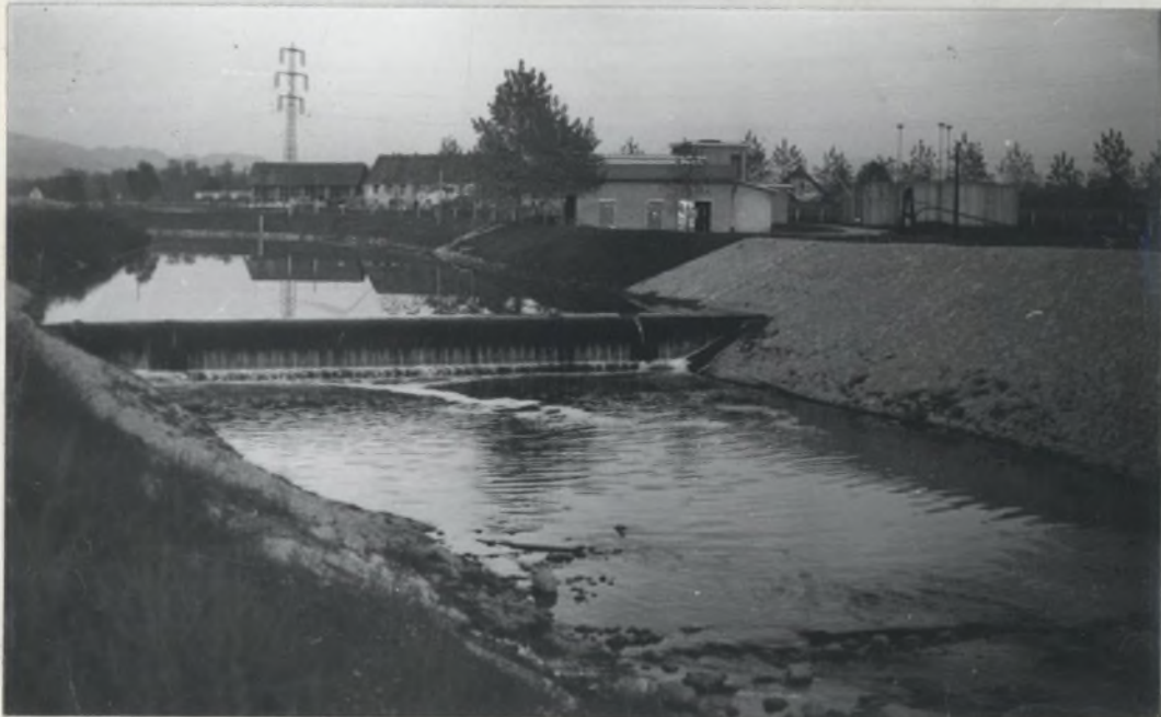
Sl.13 Nad ustjem Hudinje v Gaberju so zgradili 1976. leta takoimenovani "mehki jez", ki je prvi te vrste pri nas. Njegova konstrukcija namreč preprečuje visoki vodi, ki se nabere v celjski sovodnji, da bi prodirala po hudinjski strugi navzgor.
