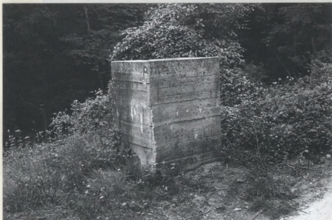
Sl.21 Od nekdanjega Kamenšekovega mlina v Grabnu pod Malo goro, ki je stal ob Landéški vodi, je ostal le betonski rezervoar. Zgradili so ga 1946.leta, ko so tudi zamenjali vodno kolo s turbino. Od rezervoarja do mlina je tekla voda po 107 m dolgem kovinastem cevovodu (premer cevi je znašal 80 mm). Mlin so opustili že pred letom 1960.
