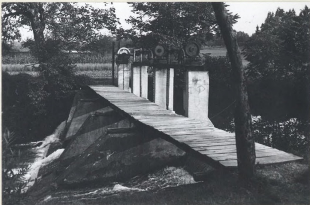
Sl.10 Florjanekov železobetonski jez: s tremi zapornicami na Hudinji pri Višnji vasi. Preko jezu vodi lesena brv. Pod njim stoji hiša z nekdanjim mlinom, ki so ga preuredili med obema vojnoma na valjce, ki jih je poganjala vodna turbina. Mlin je zaprt od 1968. leta naprej.
