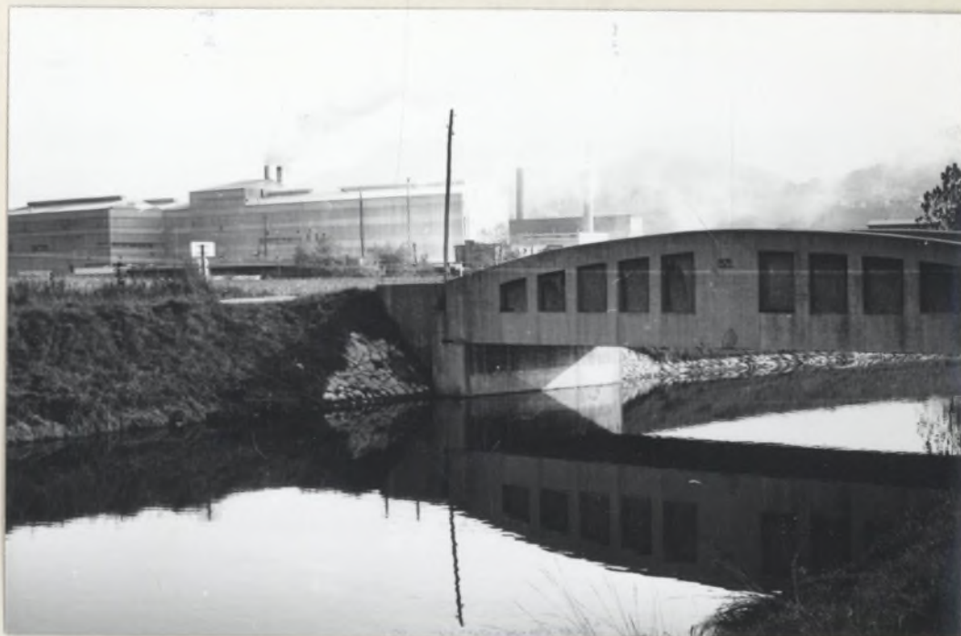
Sl.27 Bežigrajska cesta po Koštomajevem mostu prestopi Hudinjo in pelje v Bukovžlak in na Teharje. Most so zgradili 1929. leta, a ima premajhno prepustnost. Zato so se zajezile ob njem visoke povodnji in preplavile širše industrijsko območje na Spodnji Hudinji.
