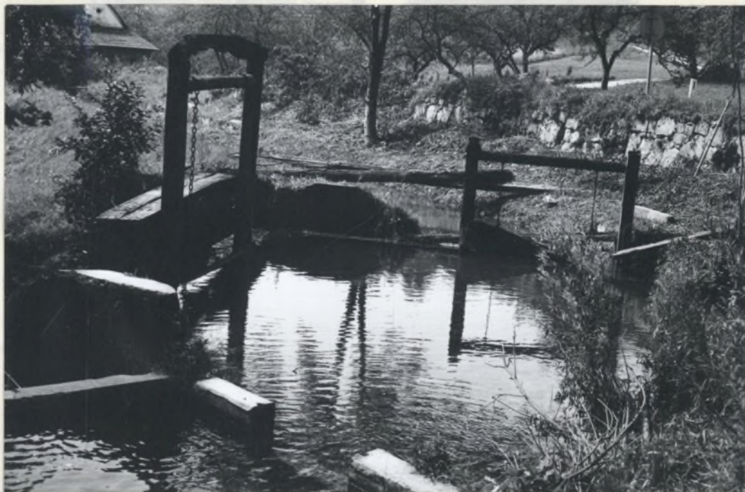
Sl.8 Tik pod izviro Toplice (v Verpetah)stoji Jerebov leseni jez na Tésnici. Od tu dalje teče voda po 60 m dolgi mlinščici do Jerebovega doma, kjer sta mlin in žaga.
