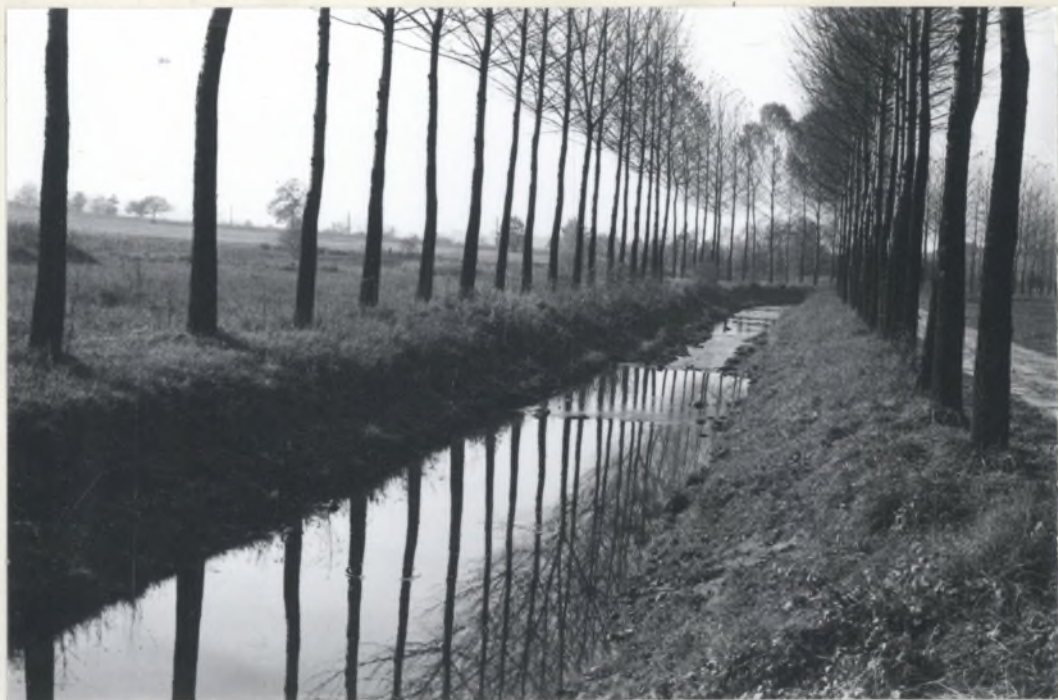
Sl.6 Z regulacijo so povečali strmec ložniški strugi. Na številnih mestih so zgradili na dnu struge lesene ali kamnite pragove, ki preprečujejo prenegli odtok nizkim vodam, obenem pa vzdržujejo željeno gladino talnice na kmetijskem zemljišču v neposredni bližini.
