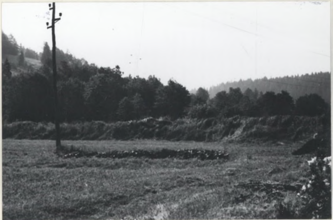
✓ Sl. 15. Nasip ob regulirani Rašici v Logu v Rašici nad Mustarjevim mlinom 12 do seže do hišnega praga
