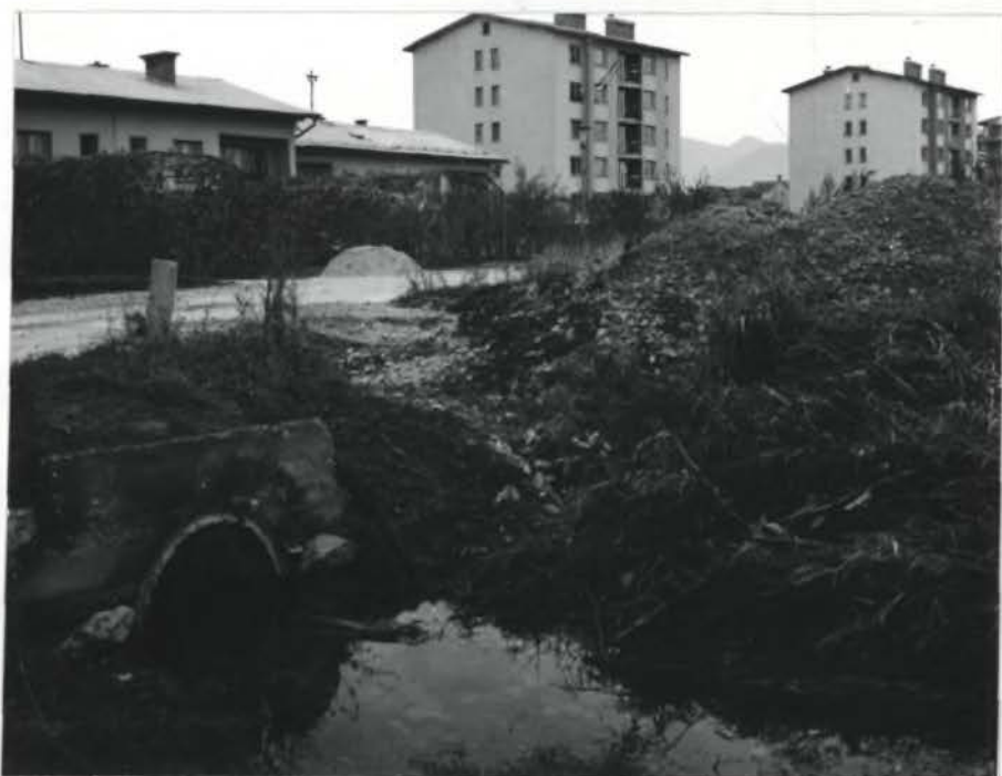
S1. 24. Narasli Godomlji, ki izvira vehitost med Gotovljami in Žalcem, ni zadostovala tale prepuščena cev pod ložniško cesto. Voda se je razlila po soseski Ložnice (severni del mesta Žalec) Indi leta 1973 in 1974;
