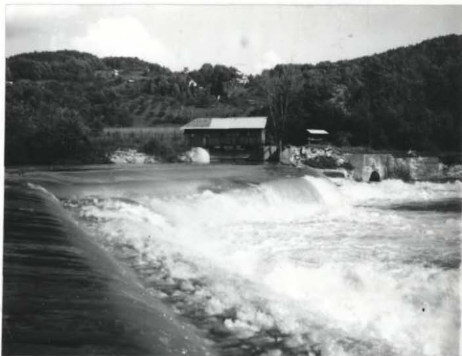
S1. 18. Podvinski jez med Zg. Podvinom in Malimi Braslovčami je največji vodni objekt na Savinji v Sp. Savinjski dolini. Napaja Podvinsko Strugo, ki je še danes pomembna pogonska moč številnih obratov. Jesenska povodenj 1973 je uničila jez, ki je že obnovljen.
