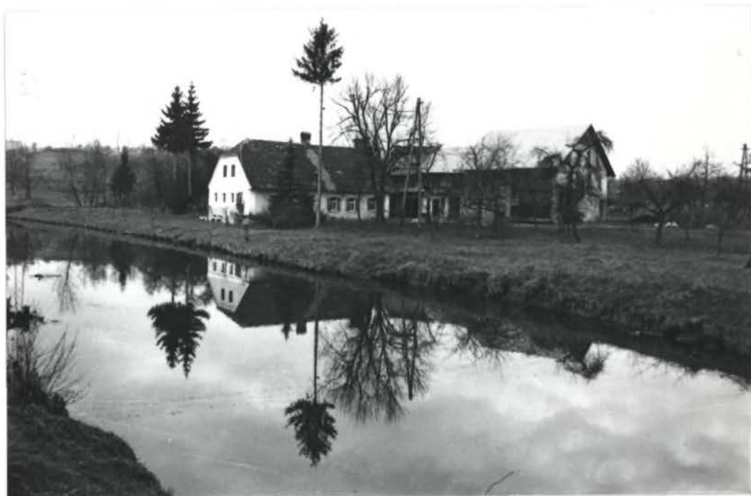
S1. 17. Za Janežičevim jezem na Ložnici zaostaja voda, na gladini katere se nabira nesnaga. Visoki vodostaj na Ložnici vzdržuje tudi visoko gladino talnice na Zg. Ložnici.
