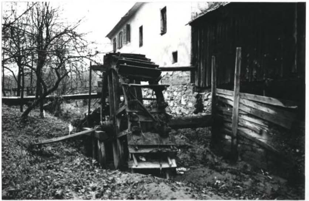
Sl. 19. Večina žag na vodni pogon je prenehala z delom. Tudi kolo Piškove žage (Lapurje, Dolenja vas) so povodnji zasule s prenašajočim gradivom.
