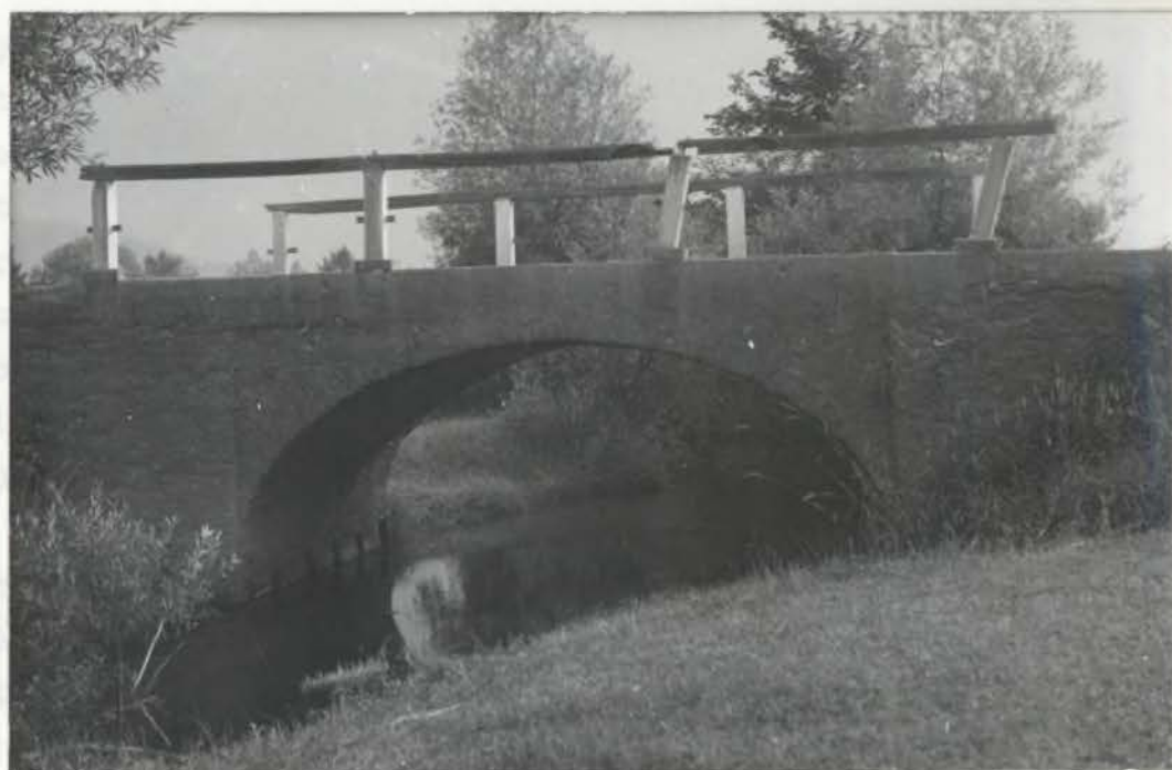
Sl. 22. Mostovi z oboki (loki) so značilni na poplavnih območjih. Zaradi izpodjedanja globinske vode so temelji nekaterih mostov zavarovani z lesenimi piloti. Na fotografiji je most čez Račno pri Hrvaškem Brodu
