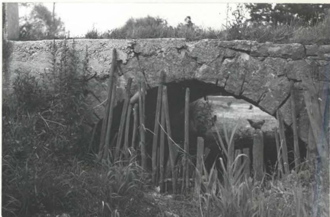
Sl. 23. Vodni prepust pod cesto Šentjernej - Dobrava pri naselju Roje. Zgornji del prepusta ima leseno "ograjbo", ki preprečuje povodnjim, da bi odnašale z dvorišč najrazličnejše predmete
