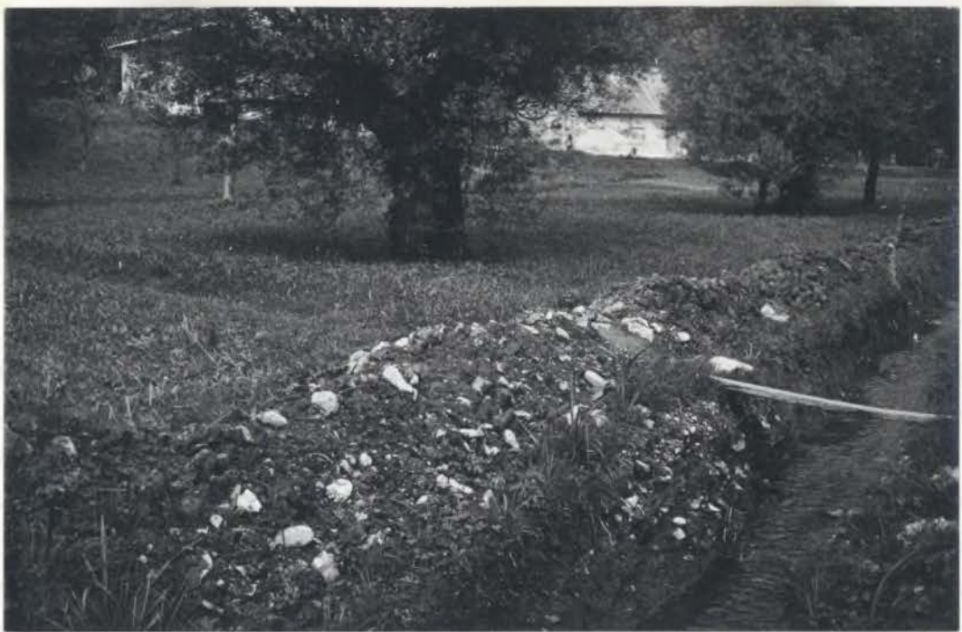
Sl. 1. Slika prikazuje na novo skopano strugo potoka Čolniščka v vasi Dolenje. V golicah so razkrite peščene ilovice pa tudi plasti debelega apniškega drobirja s katerim so posipali stari kolovoz, ki ga označuje čez potok položena deska, viden pa je tudi v travi na levi strani slike.
