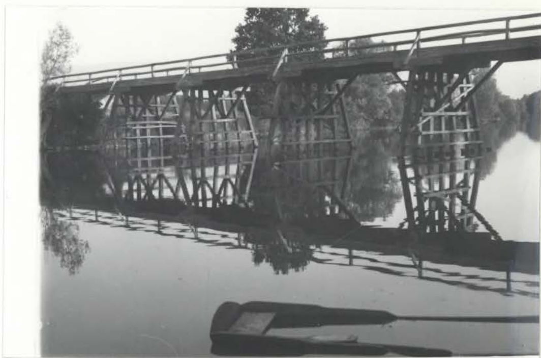
Sl. 25. Eden izmed značilnih lesenih mostov na Krki. Širino reke so premagali z večjim številom (leseni) nosilnih opornikov ("joh"). Čoln pod njim ne služi več prevozu čez Krko, temveč le še ribičem. Fotografija je iz Mršeče vasi
