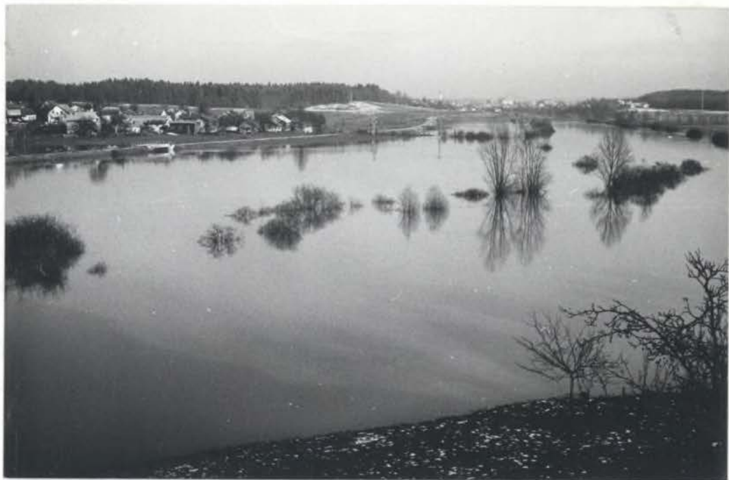
Sl. 5. Pogled od vasi Zalog po poplavljenem svetu Krke proti Češči vasi in Novem mestu /8. decembra 1976/.
