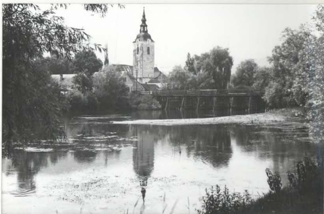
Sl. 26. Kostanjevica na Krki stoji na poplavnem svetu. Dostop v mesto na otoku je mogoč po dveh lesenih mostovih ter brvi. Pogled na zahodni most, ki je naslonjen na številne lesene opornike
