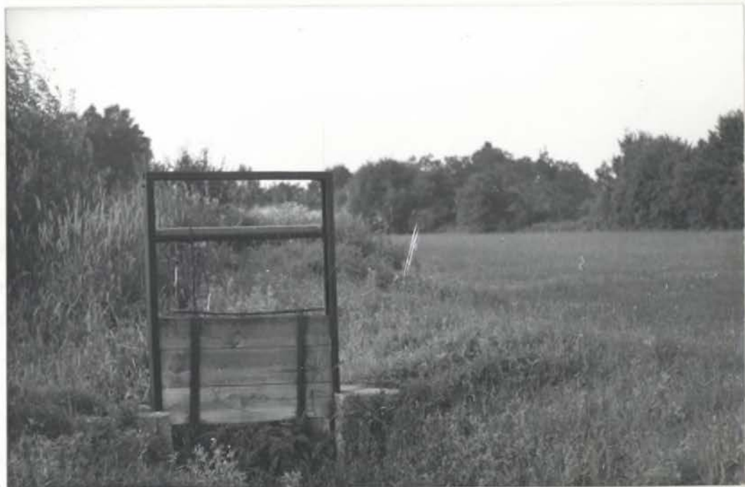
24 Sl. 3. Opuščeni jez na Velikovaškem potoku (levi pritok Senuške), kateri je služil za odvajanje poplavnih voda v razbremenilnik. Jez stoji sredi Travnikov med Gržečo vasjo in Velikim Podlogom
