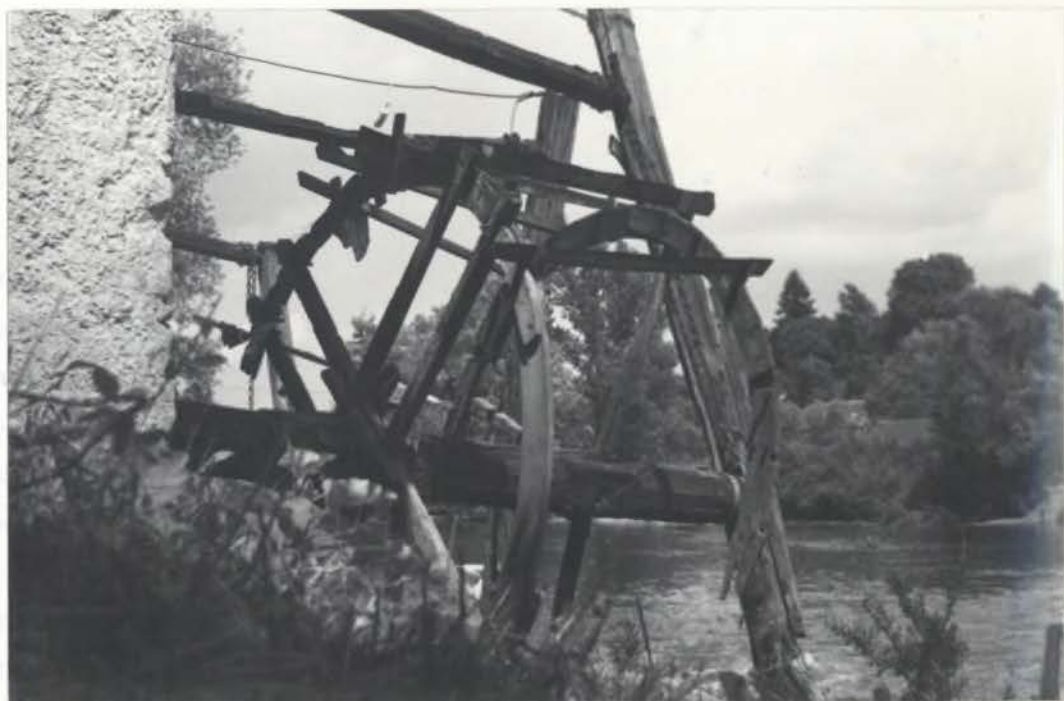
Sl. 17. Razpadajoče vodno pogonsko kolo Dvornikovega mlina v Krški vasi. Nekdaj je imel mlin kar 5 pogonskih koles, ki so jih v letih med obema vojnama združili v eno samo veliko kolo na lopate. Mlin so opustili sredi 60.let
