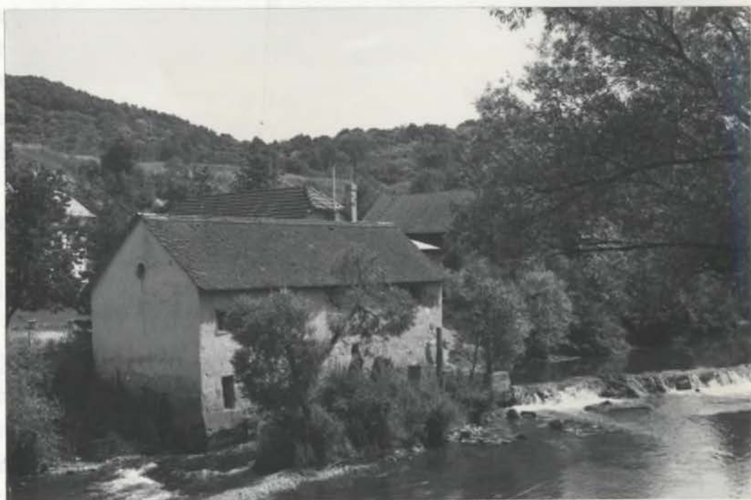
Sl. 16. Tudi Lopatičev mlin na Krki (Velike Malence) so opustili po drugi svetovni vojni. Do leta 1955 so 4 kolesa na lopate poganjala 4 pare kamnov. Tedaj so pogon preuredili na eno veliko kolo, ki je poganjalo obrat vse do njegove opustitve v letu 1959
