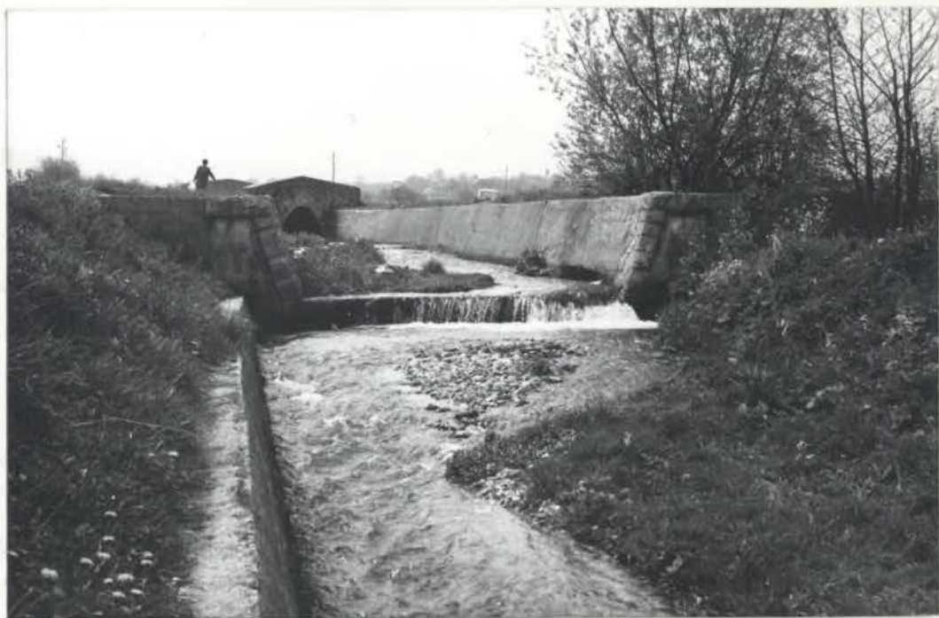
22 Sl. 1. Hudourniško Kobilščico, ki je povzročala mlinarjem in žagarjem obilo skrbi, so večkrat regulirali. Pogled na del njene zavarovane struge med Dolenjo Brezovico in Dolenjim Vrhpoljem
