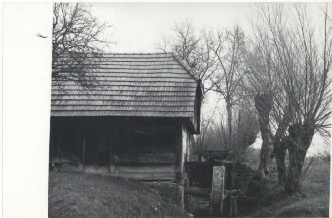
Sl. 15. Malenškov mlin na Lokavcu (naselje Zaloke) je bil opuščen 1974. leta. Mlin je imel leseno stavbo, v kateri sta bila dva para kamnov in stope. Poganjali so ga trije kolesi na korce
