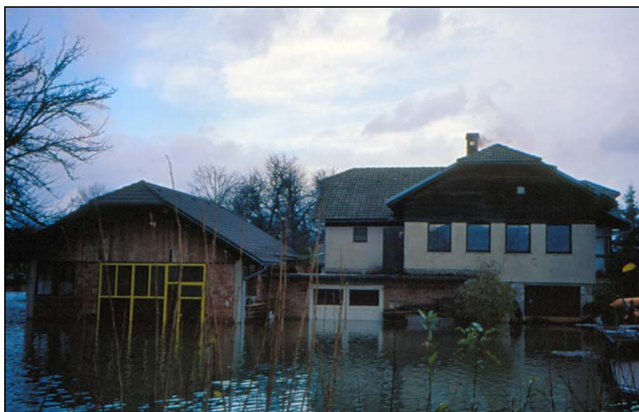
Slika 1: Stanovanjska hiša v vasi Dolenje Jezero, zgrajena na izpostavljenem območju, ob poplavah leta 2000 (fotografija: Nataša Ravbar).
