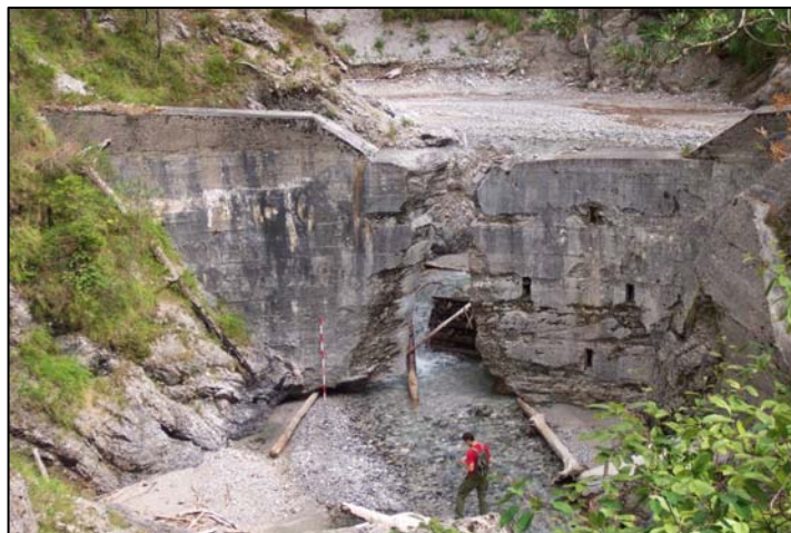
Slika 1: Poškodovana zaplavno-ustalivena pregrada (hudournik Belca).
