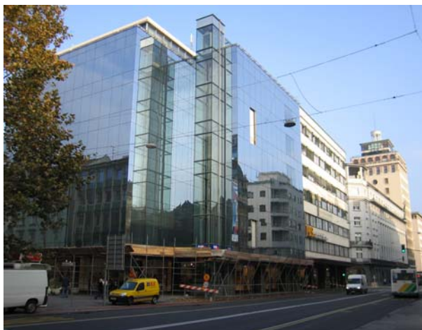
Sliki 4 in 5: Odpadanje fasadnih plošč veleblagovnice Nama v Ljubljani in vogalno okno individualne hiše. Prenašanje tujih vzorov vodi v poslabšanje varnostnih razmer na fasadi oziroma v najbolj občutljivem vogalnem delu konstrukcije (fotografija: Domen Kušar).
