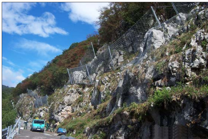
Slika 4: Kombinacija primarnega (prekritje z varovalnimi mrežami) in sekundarnega načina (podajne lovilne varovalne ograje) varovanja cestnih prometnic pred padajočim kamenjem (zaščita regionalne ceste Kalce–Col).
