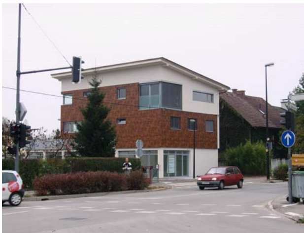
Sliki 4 in 5: Odpadanje fasadnih plošč veleblagovnice Nama v Ljubljani in vogalno okno individualne hiše. Prenašanje tujih vzorov vodi v poslabšanje varnostnih razmer na fasadi oziroma v najbolj občutljivem vogalnem delu konstrukcije (fotografija: Domen Kušar).
