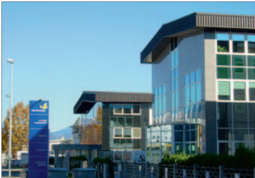
Slika 6: Obdobje ob prelom tisočletja je bilo v Sloveniji investicijsko ugodno. To je veljalo še zlasti za območje Ljubljane, kjer so zrastle številni objekti, kakršne so nove poslovne stavbe v trzinski poslovno-industrijski coni.
