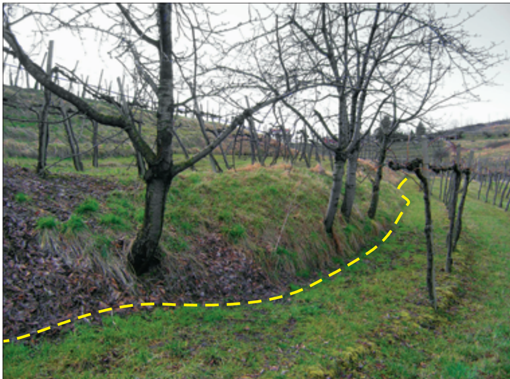
Slika 142: Isti zemeljski plaz kot na prejšnji sliki, prikazan od blizu. Z rumeno črto je označena izbočena terasna ježa, na kateri so zaradi plazanja upognjena tudi debla sadnega drevja.
