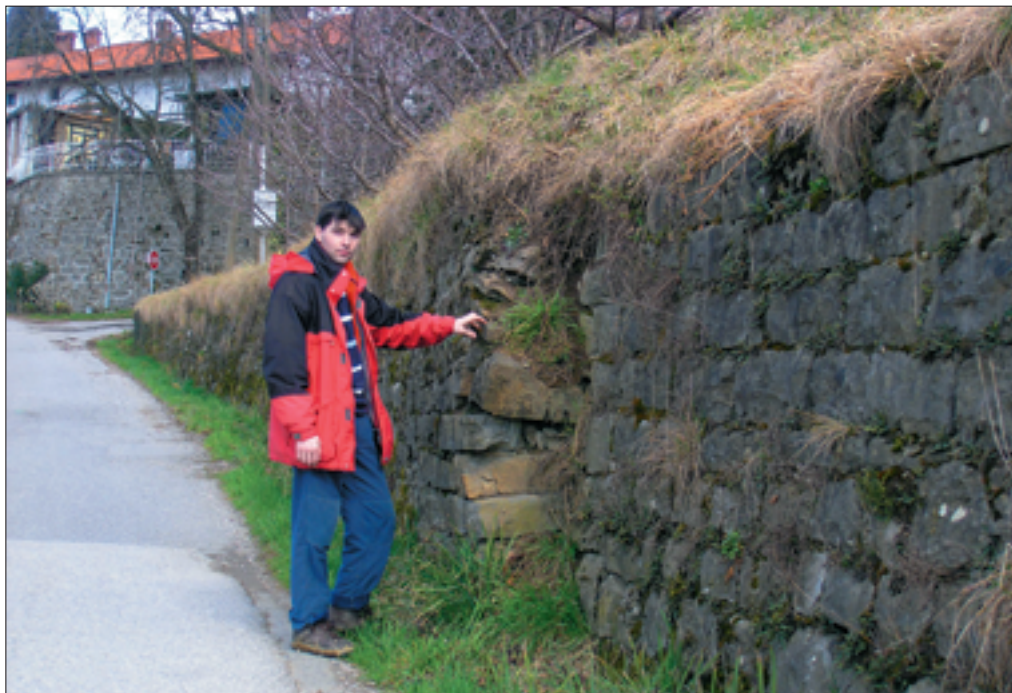
Slika 147: Izbočeni kamniti zidovi nad useki cest zaradi plazenja.
