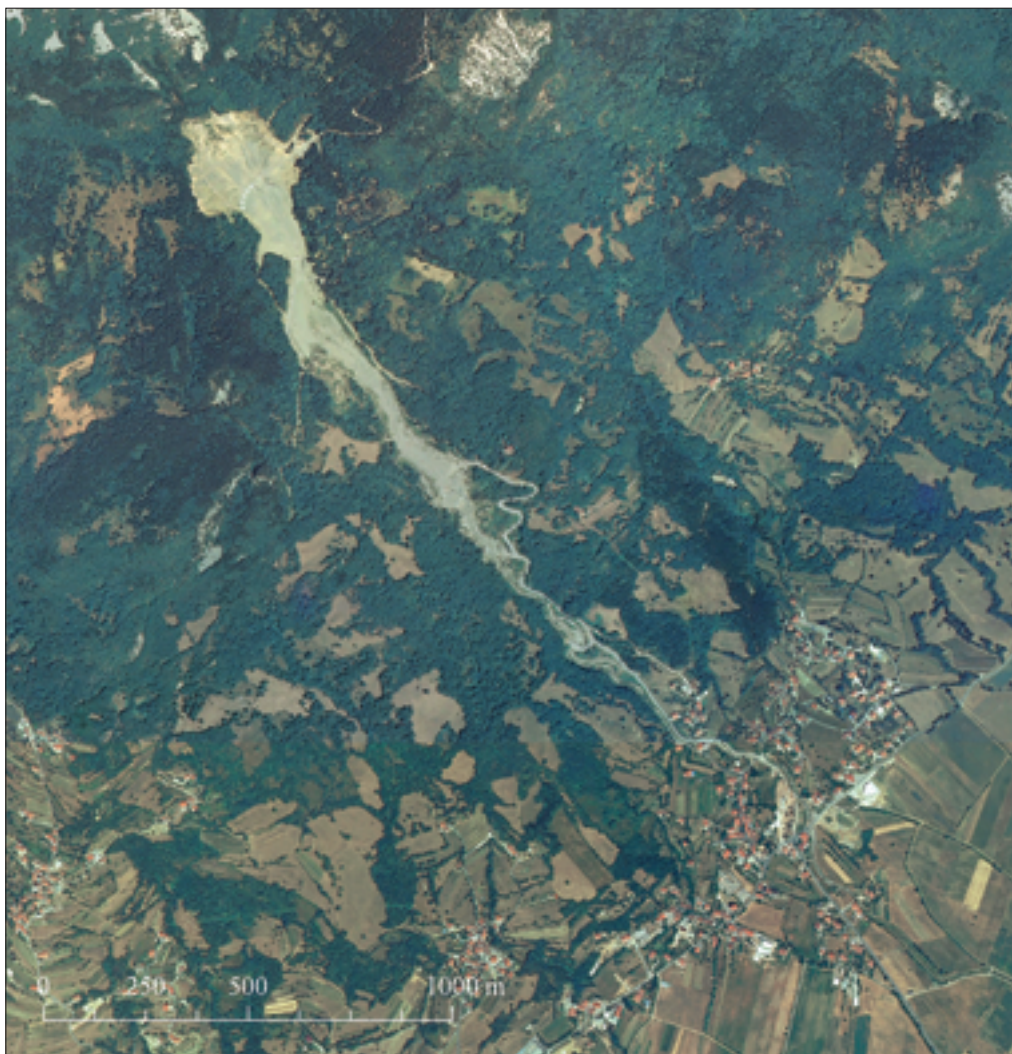
Slika 131: Zemeljski plaz Slano Blato ogroža naselje Lokavec v Vipavski dolini (© Geodetska uprava Republike Slovenije 2005).
