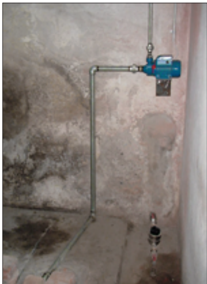
Slika 44: Iz večjih globin črpajo podtalnico tudi z električnimi črpalkami.
