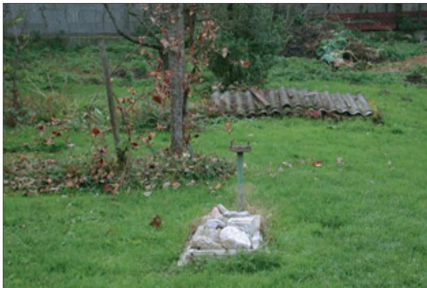
Slika 35: Zabiti vodnjaki so brez izjeme kovinski.
